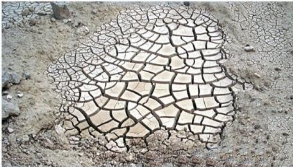
Figure I-1 : sol expansif montrant des fissures (Ifsttar et Armines, 2017).
