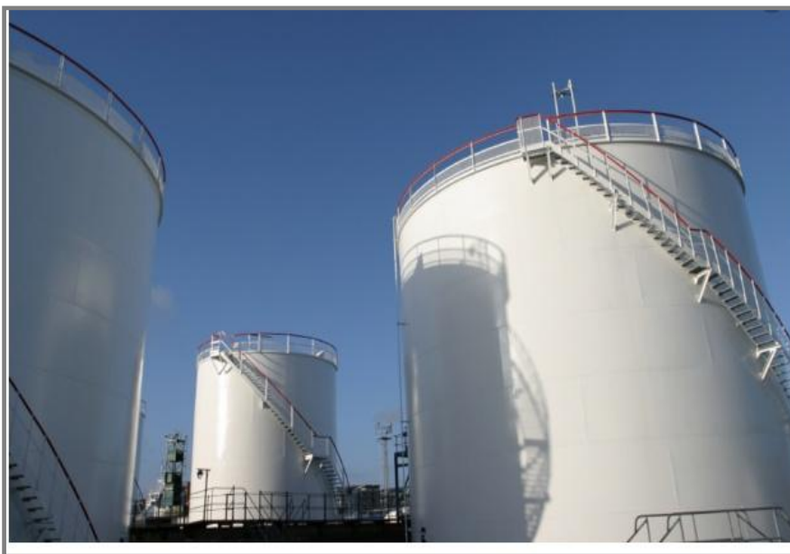
Fig. 1. 2 Réservoirs cylindrique de stockage des produits Pétroliers Liquides
