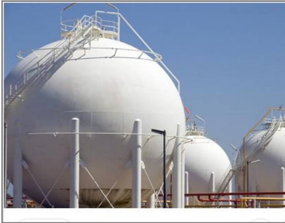
Fig. 1. 3 Réservoirs sphérique de stockage des Gaz Pétrolier Liquide
