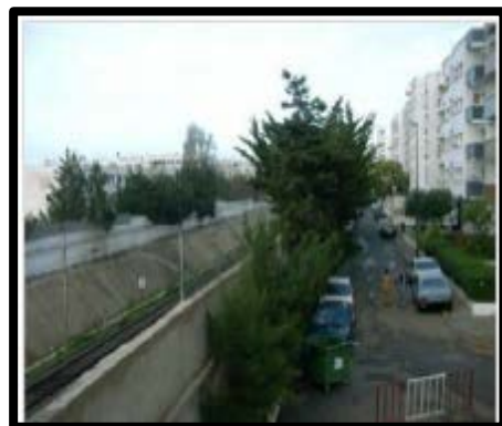
Image : Le deuxième tronçon au niveau du bas Agdal où les immeubles résidentiels en R+4 sont omniprésents.
