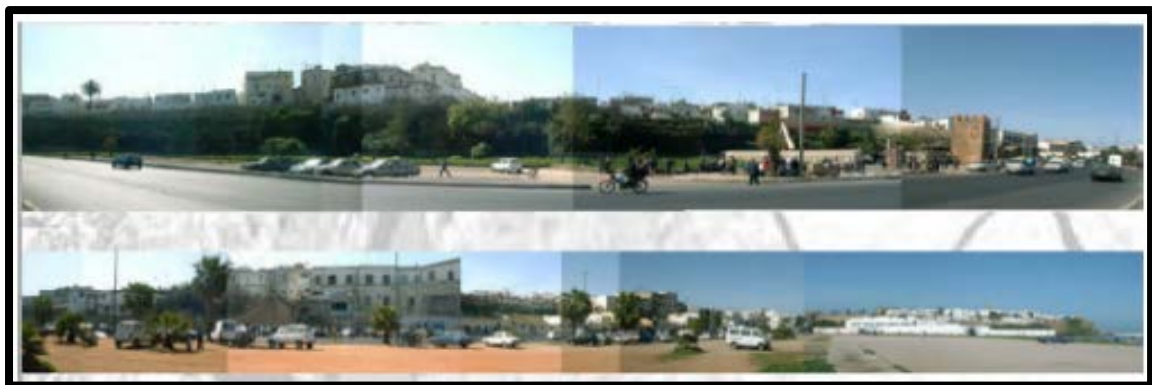
Vues panoramique de la façade fluvial du médina
