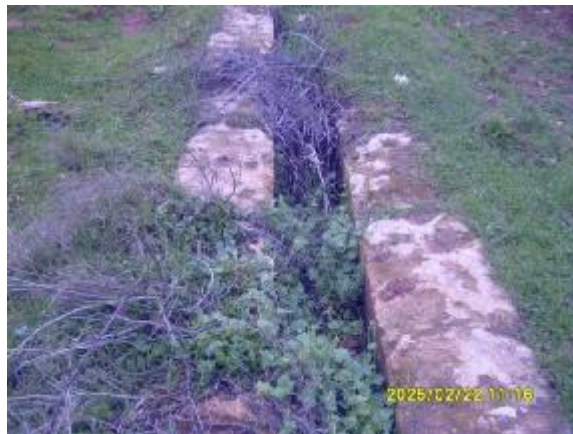
Figure 14 : Le canal de transport d'eau
