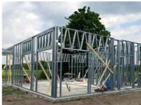
Figure 106 : structure métalliques pour bungalows
