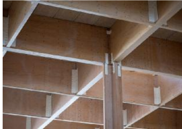
Figure 150 : structure en bois du marché
