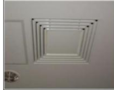
Figure 107:bouches d'extraction
