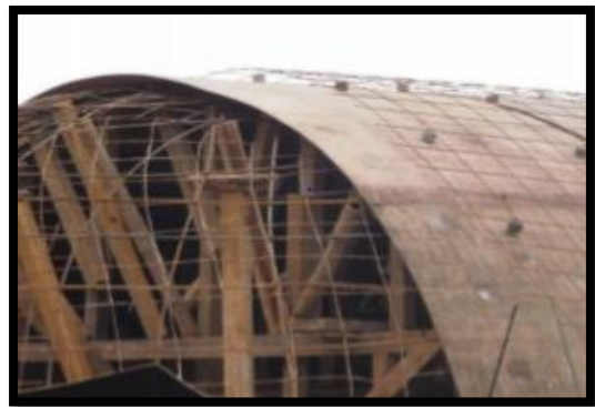
Figure 91: mise en place du coffrage et armature
