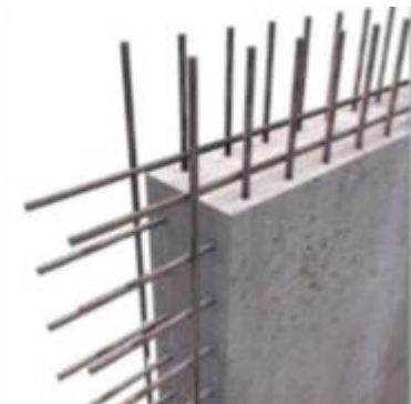
Ferrailage d'un voile en béton
