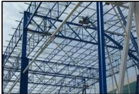
**Figure 110:** Poutre en treillis .
