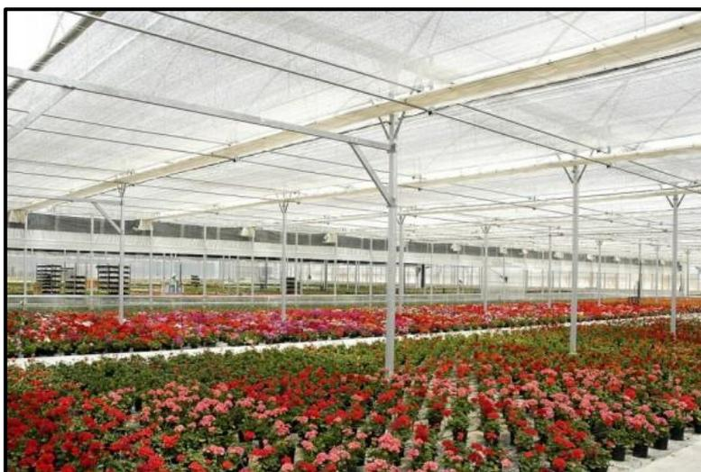
**Figure 150 :** Les écrans thermique ,
