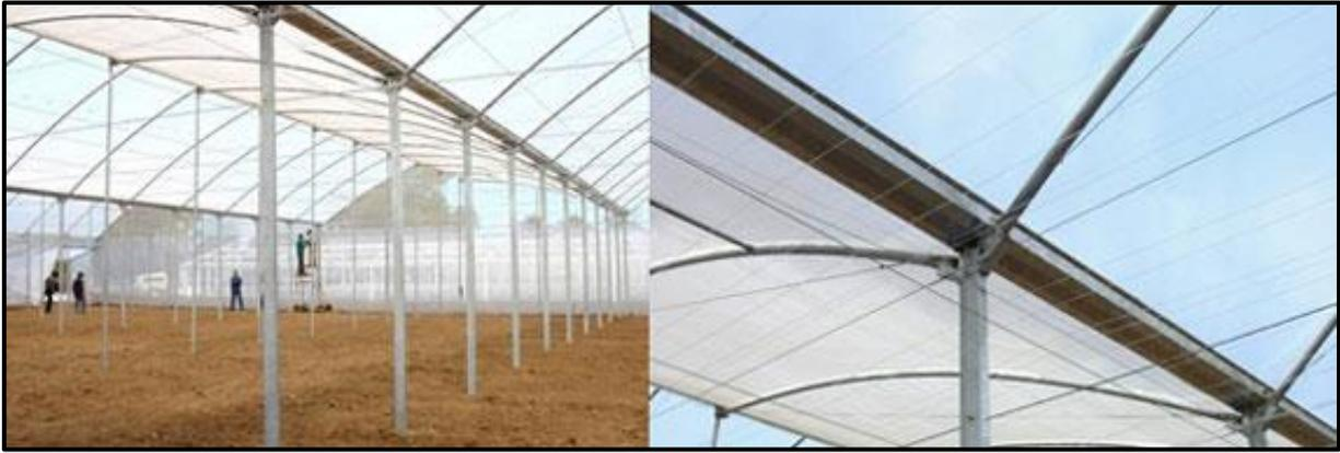
**Figure 144 :** la gouttière des serres , **Source :** <https://www.invernaderosima.com/>
