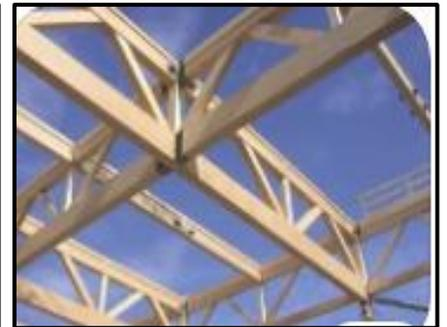
**Figure 111:** Poutre en treillis en V
