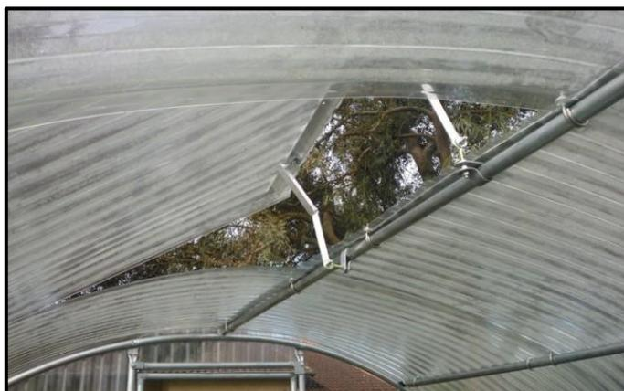
**Figure 149 :** Aération des serres , **Source :** <https://komat.fr>
