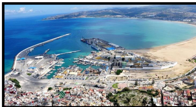
Figure37 : le port de Tanger avant le projet
