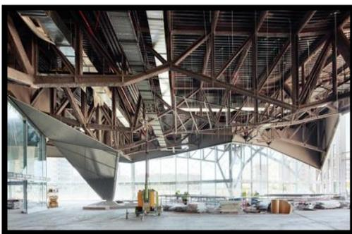
Figure 97 : structure en treillis métallique du projet
