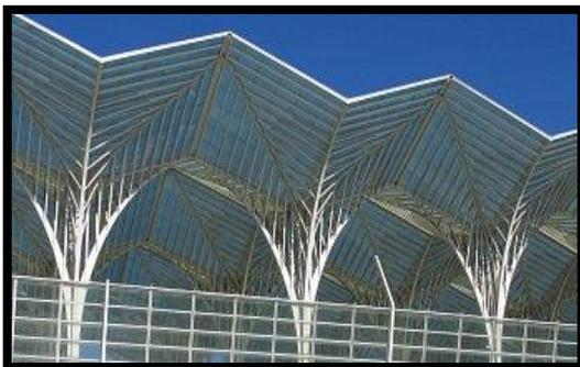
Figure 15 : couverture plissée au niveau des quais
