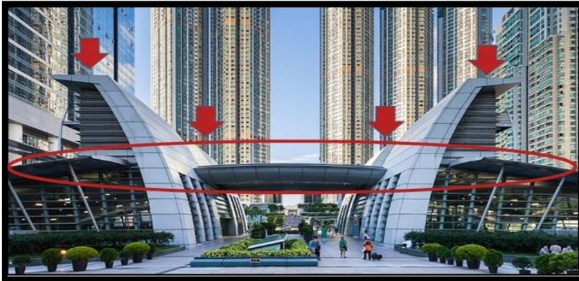
Figure 3 : Structure hybride sous forme d'une voûte en acier et 4 tours en béton
