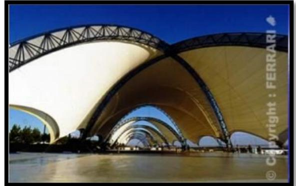
Figure 14 : couverture à double membranes tendues
