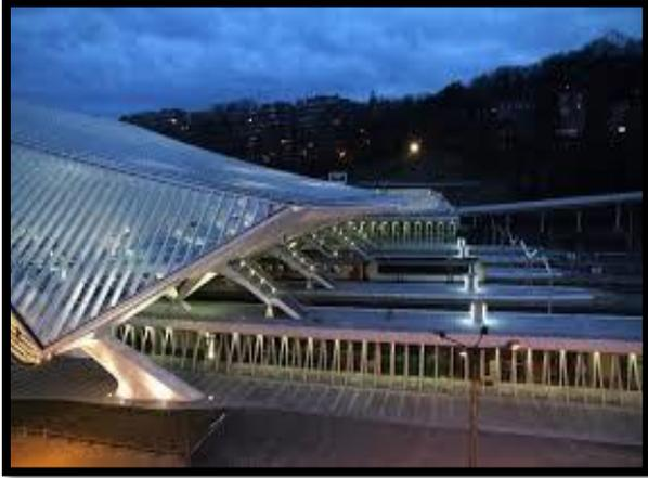
Figure 109,110 : réseau d'arc qui supporte la structure de la gare
