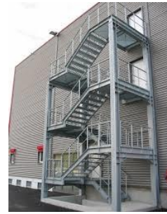
Figure 52: escalier de secours a l'extérieur
