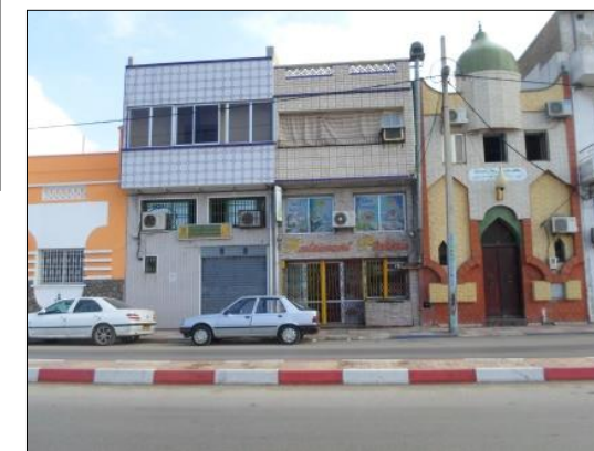
Figure 33 : Construction en bonne état
