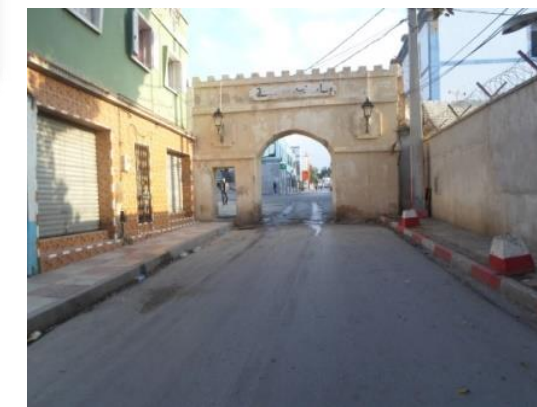
Figure 11: Voie secondaire (Porte de Nedroma)
