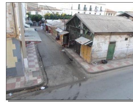
Figure 24 : Marché couvert RDC
