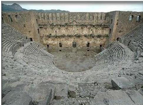
**Figure 2.** Théâtre construit en terrain plat sur voûtes et arcades (fermé).
