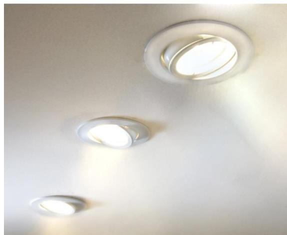
**Figure 129.**Les spots encastrés au plafond.
