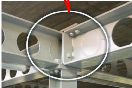
Figure 164 : les poutres alvéolaires
