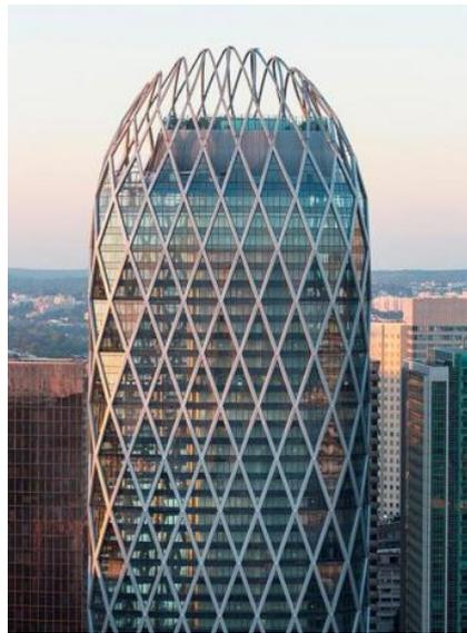
Figure 26:tour2d avec exosquelette en acier
