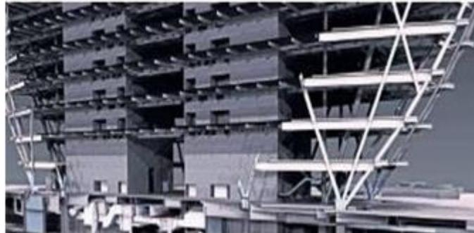
Figure 175 : l'articulation des dalles mixte avec le noyau central
