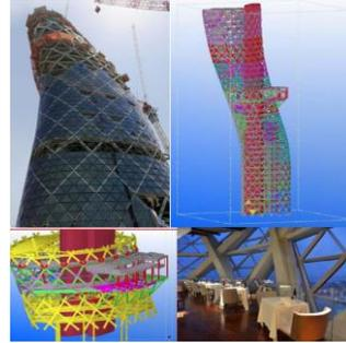
Figure 28:Le système diagrid Figure 29:Capital Gate : La construction de la tour en système diagrid en acier <sup>28</sup>
