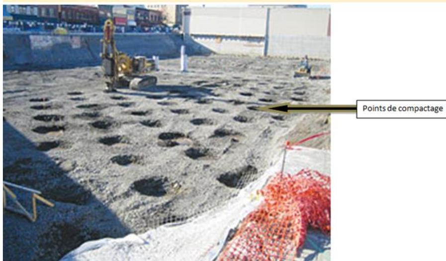
Figure 187 : chantier de compactage
