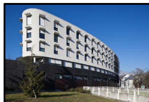
Figure 26 : la façade de bâtiment
