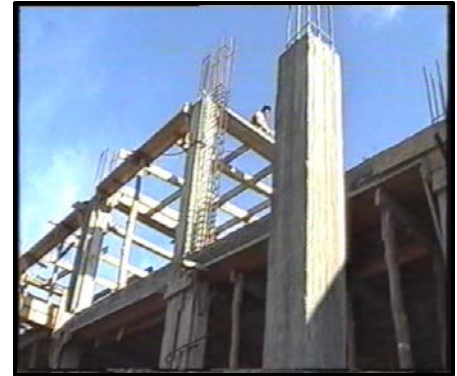
Figure 55 : structure en Béton armé
