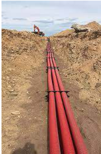
Figure 9 : Photos de canalisation
