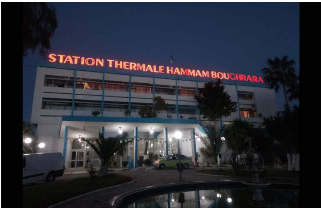
Figure 3: Vue de l'Hôtel de Hammam Boughrara
