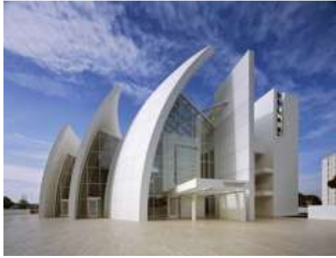
Figure20 : bâtiment réalisé avec les bétons autonettoyants et dépolluants 20
