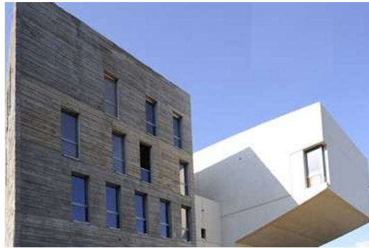
Figure21 : bâtiment réalisé avec les bétons de fibres polypropylène 21
