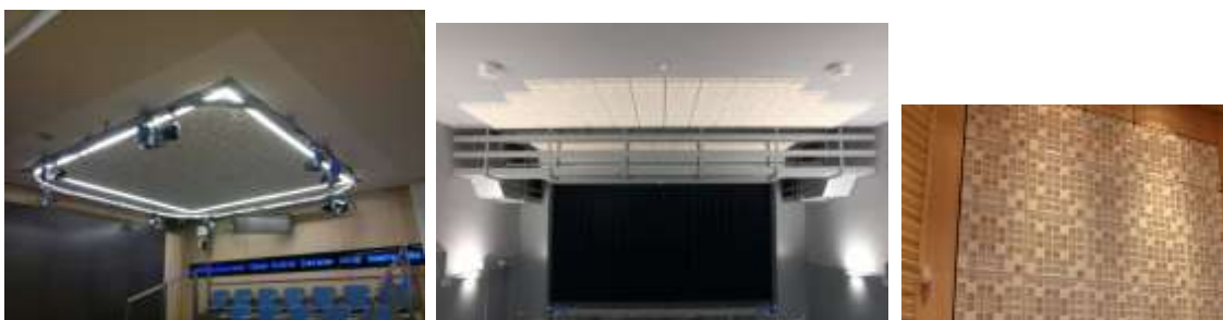
Figure85 : diffuseur acoustique au plafond pour une salle de projection. 94
