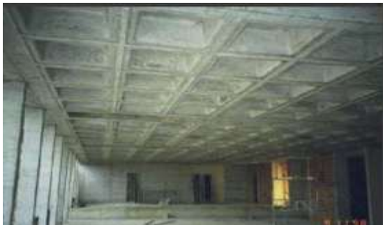
figure72 : plancher à caisson.
