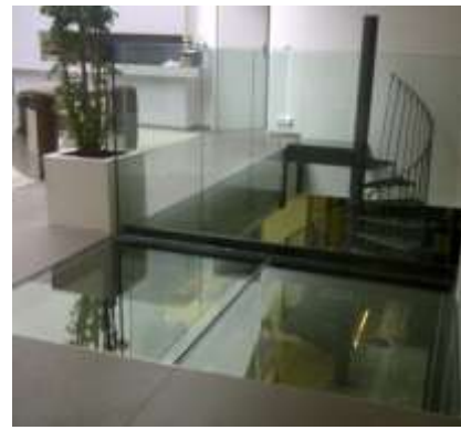
figure26 : Le plancher sol en verre 25
