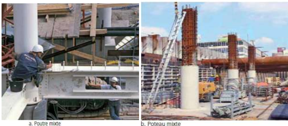
Figure68 : éléments porteurs avec structure mixte. 79
