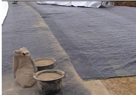
FIGURE 1.17 : LES GÉOSYNTHETIQUES BENTONITIQUES (©AFITEX)
