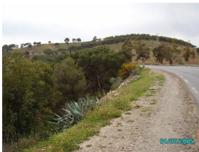
PHOTO 1.7 : UN TRONÇON DE LA RN 22 AVANT DÉDOUBLEMENT
