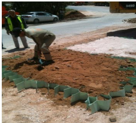
PHOTO 4. 4 : REMPLISSAGES D'ALVÉOLAIRE PAR LE SABLE D'EL BORDJ ET TOUT-VENANT
