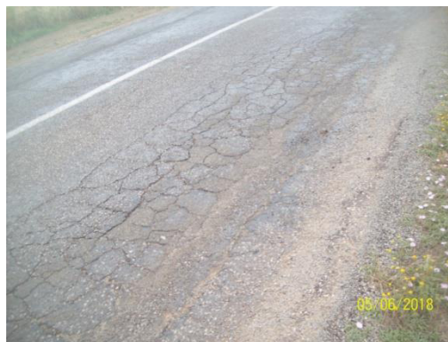
PHOTO 1.2 : FISSURES EN CARRELAGE (CW110, 2018)
