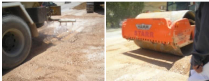
PHOTO 4. 5 : OPÉRATIONS D'ARROSAGE ET COMPACTAGE
