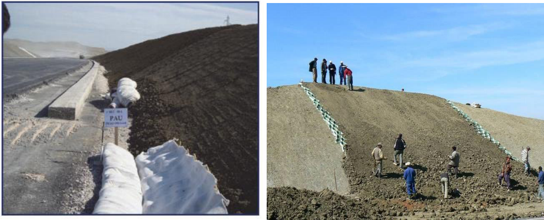
PHOTO 1.10: STABILISATION DES TALUS AUTOROUTES EST OUEST (CÔTÉ OUEST)
