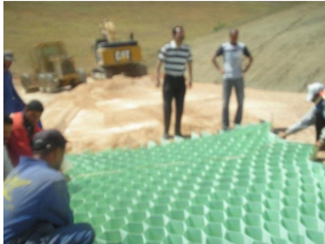
PHOTO 4. 3 : MISE EN PLACE D'UNE COUCHE ALVÉOLAIRE SUR LA COUCHE DE BASE
