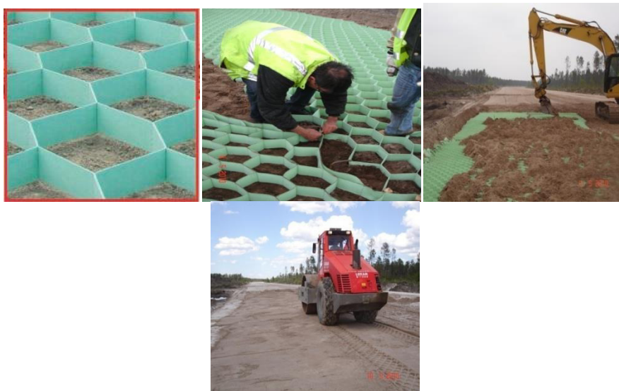
PHOTO 1.6 : MISE EN ŒUVRE DE GÉOSYNTHÉTIQUE ALVÉOTER ® 20 RDT
