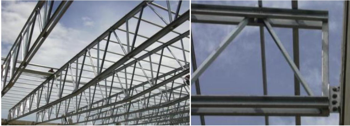
Figure 2.7 Toit en ferme exposé (Mei et al., 2009)
