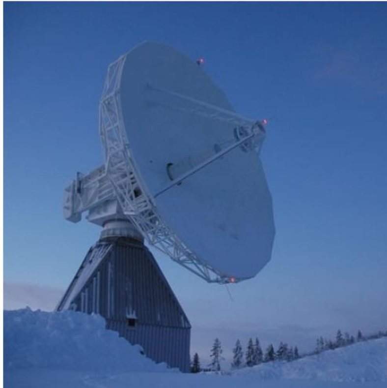
Figure I.14: Antenne parabolique TTCF bande S 11 m (gracieuseté de l'ESA) [9].
