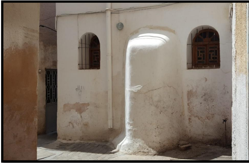
الواجهة الشرقية للمسجد.
