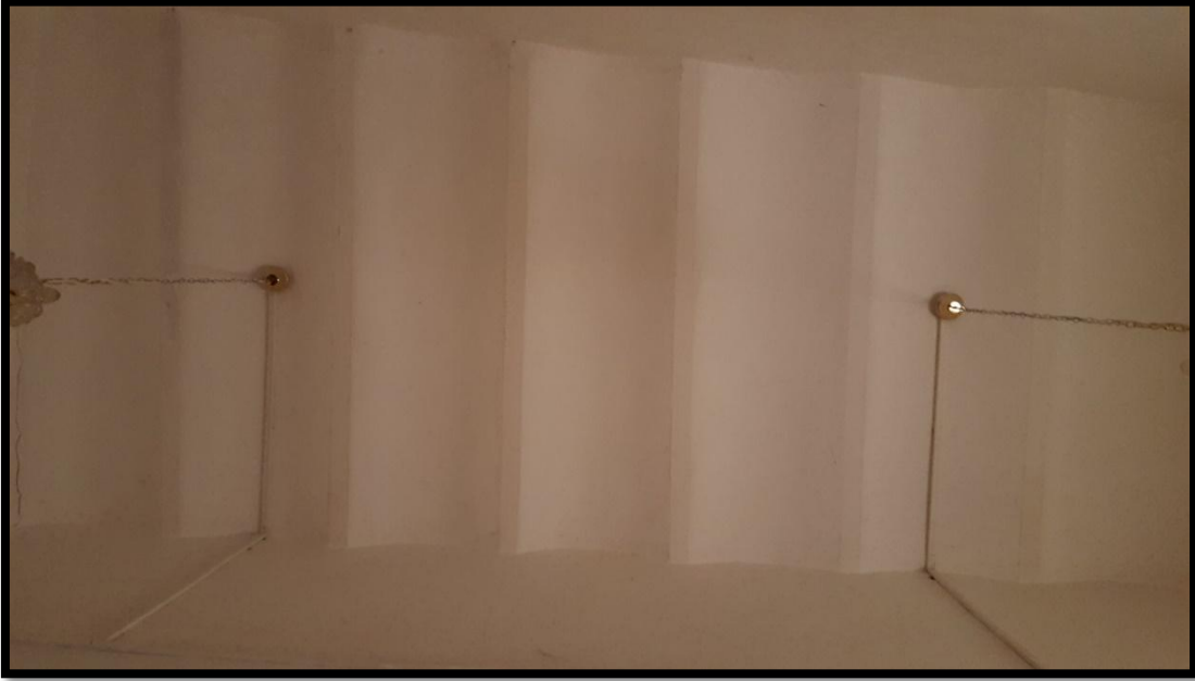
الصورة رقم 05 : سقف بيت الصلاة من الداخل
