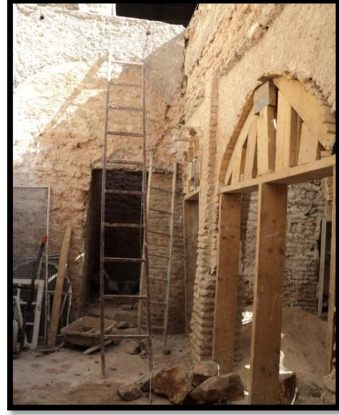
الجدران أثناء عملية الترميم
