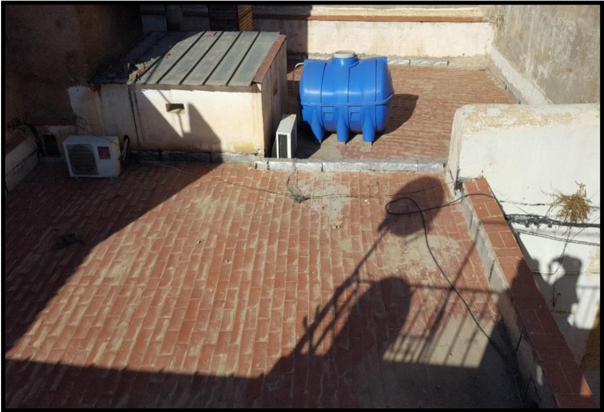
الصورة رقم 02 : سقف بيت الصلاة من الخارج
