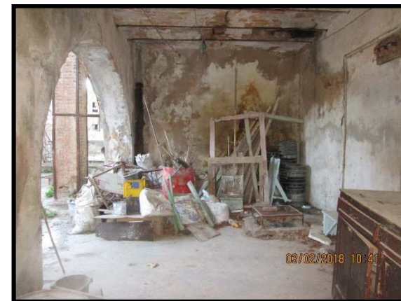
الصورة 68: الجهة الجنوبية للسطح
