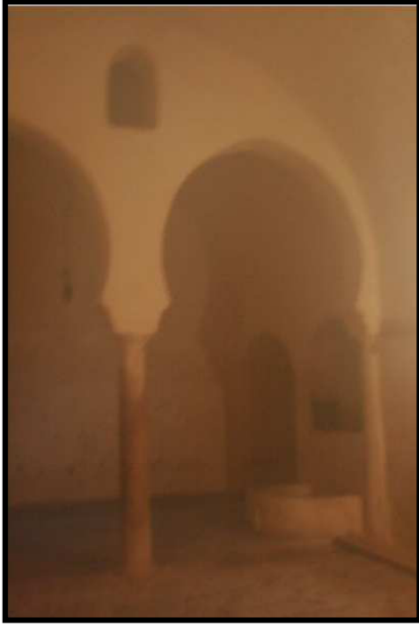
الصورة 43: البائكة الشمالية
