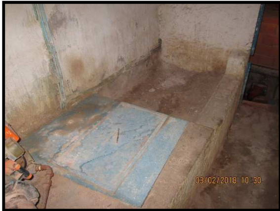
الصورة 49: صهريج الوقود
