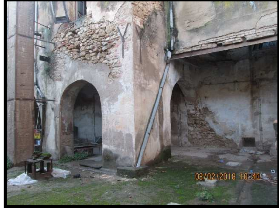
الصورة 66: الجهة الجنوبية للسطح
