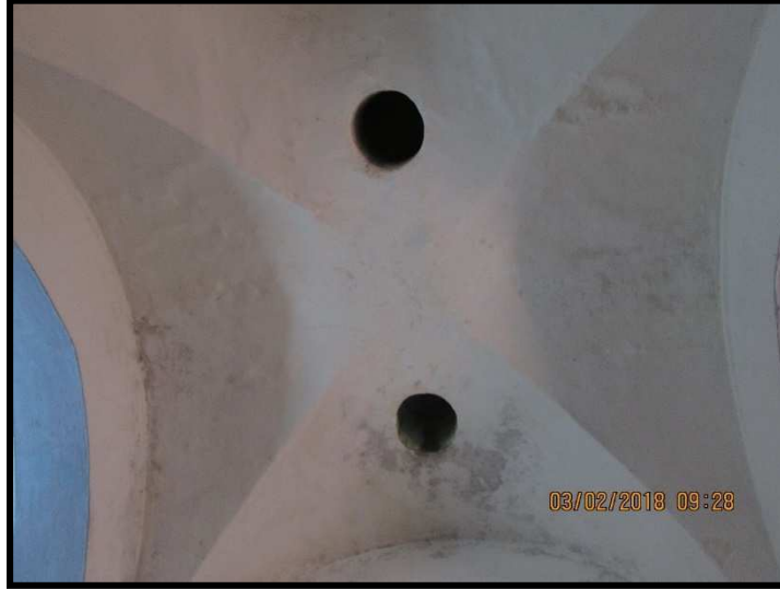
الصورة 27: سقف ذو أقبية متقاطعة
