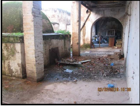
الصورة 67: الجهة الجنوبية للسطح
