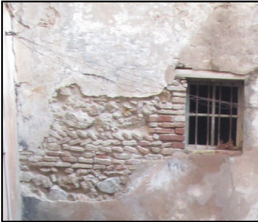
الصورة 77: استخدام الآجر بتقنية السنبلة
