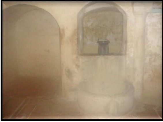
الصورة 38: صهريج الماء الساخن
