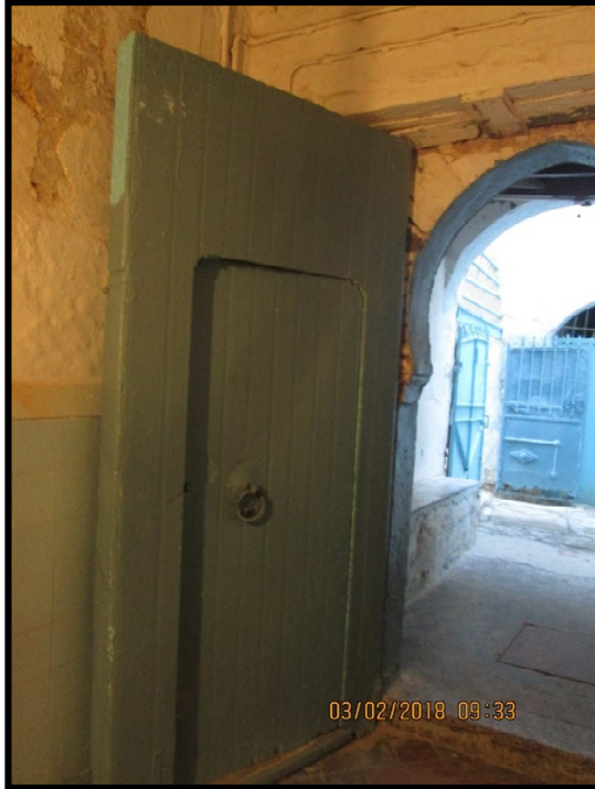
الصورة 7: مدخل الجزء الثاني من السقيفة
