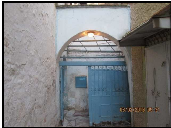
الصورة 1: مدخل الحمام
