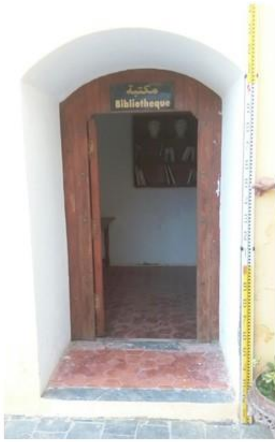
الصورة رقم: (59) باب في الواجهة الداخلية الشرقية لحصن الترك
