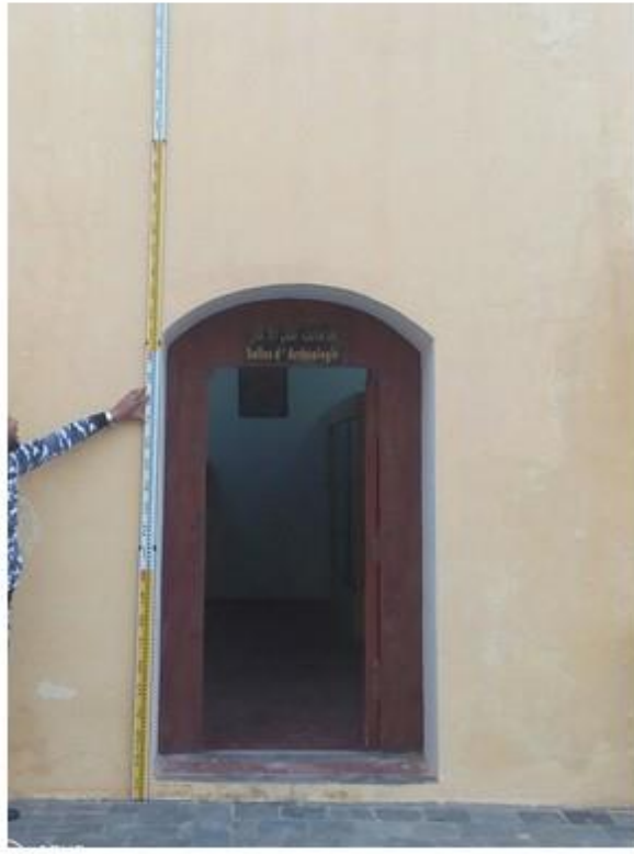
الصورة رقم (55) باب في الواجهة الداخلية الجنوبية لحصن الترك
