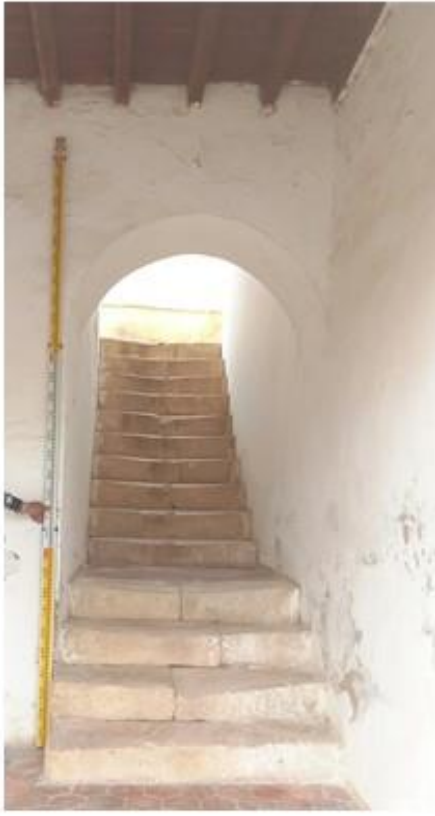
الصورة رقم: (69) الدرج المؤدي للسطح حصن الترك
