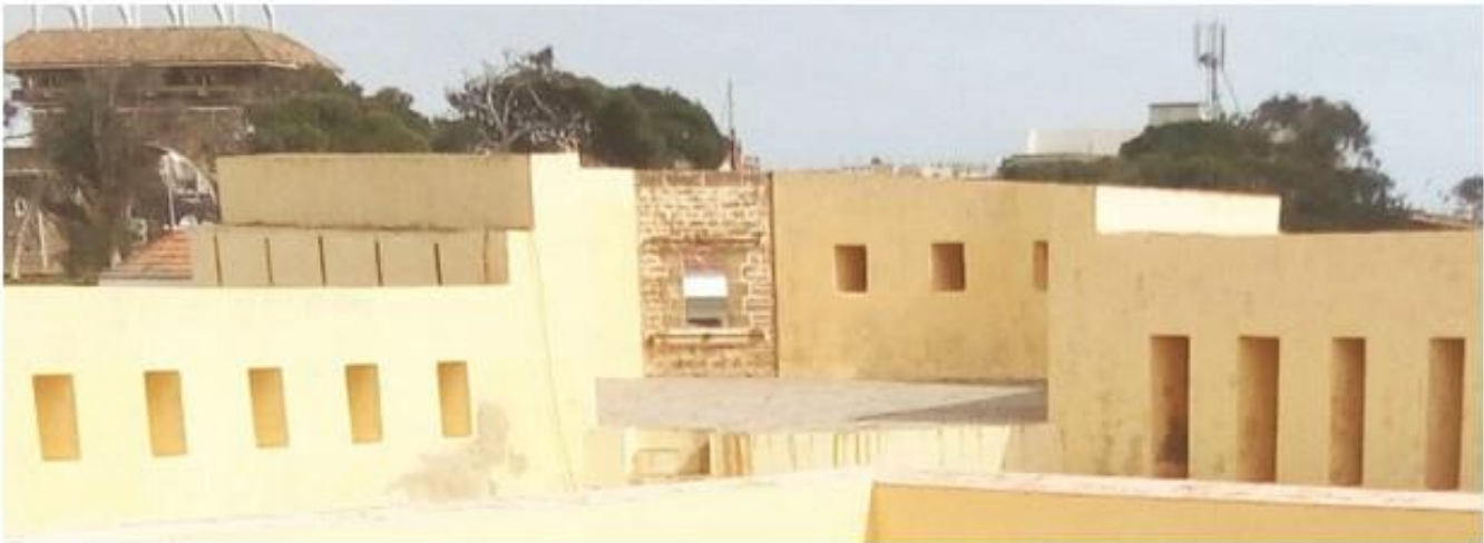
الصورة رقم (78) الجدار الساتر للبرج الشمالي الشرقي "حصن الترك"
