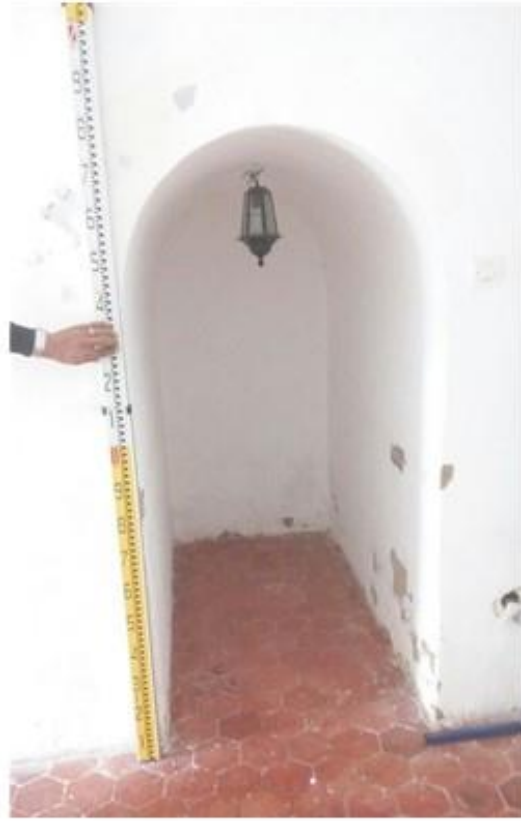
الصورة رقم: (68) فتحة تحت الدرج حصن الترك
