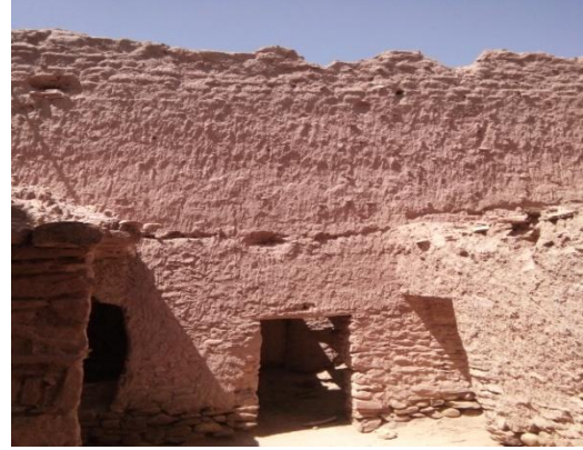
صورة رقم 14: تمثل طريقة بناء الجدران بالمرزج أو المتناوية في قصر بوسمغون
