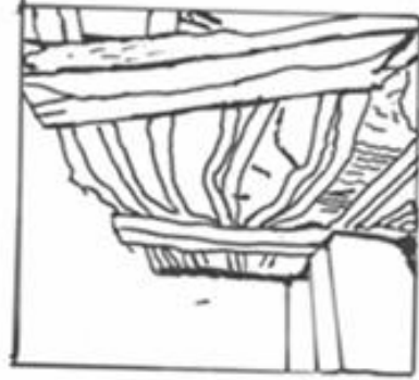
الشكل رقم 18: يمثل طريقة التسقيف في قصر الشلالة
