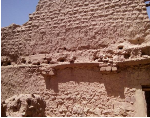
صورة رقم 14: تمثل طريقة بناء الجدران بالمرزج أو المتناوية في قصر بوسمغون
