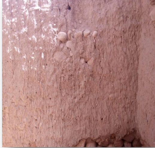
صورة رقم 16: تمثل طريقة الكسبة في قصر بوسمغون
