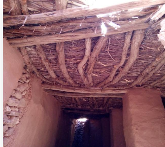
صورة رقم 28: تمثل طريقة التسقيف في قصر الشلالة
