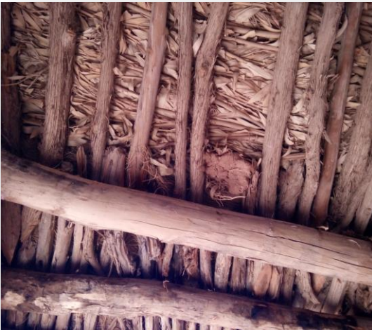
صورة رقم 28: تمثل طريقة التسقيف في قصر الشلالة
