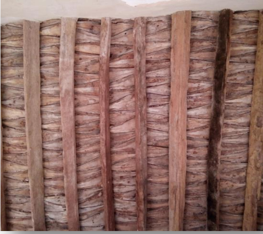
صورة رقم 29: تمثل طريقة التسقيف في قصر بوسمنون
