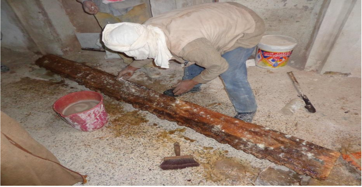
الصورة رقم 14: معالجة العوارض الخشبية بالطريقة التقليدية (الماء و الملح )
