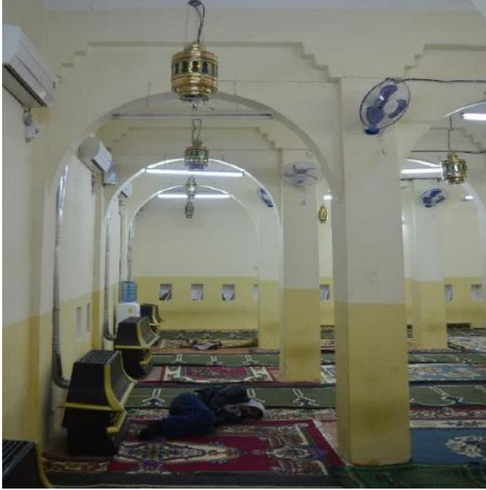
الصورة رقم 9: شكل الاعمدة و الاقواس في الجزء المستحدث
