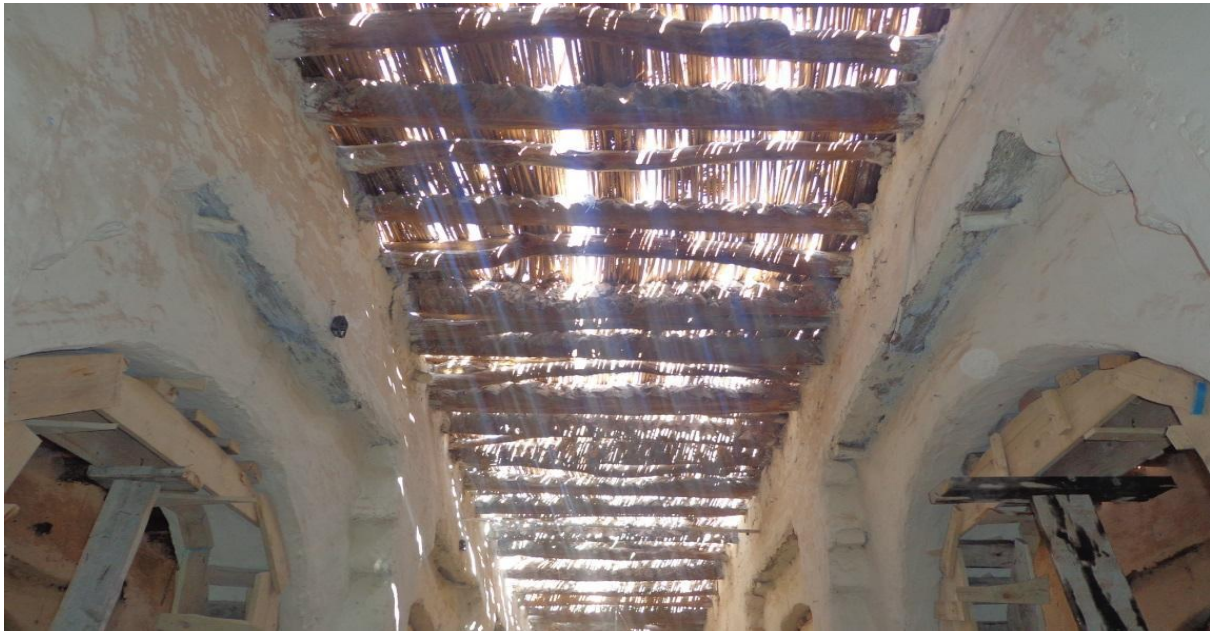
الصورة رقم 13: استبدال العوارض الخشبية من نفس النوع
