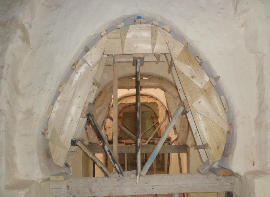
الصورة رقم 18: تدعيم الاقواس و السقف بدعامات خشبية
