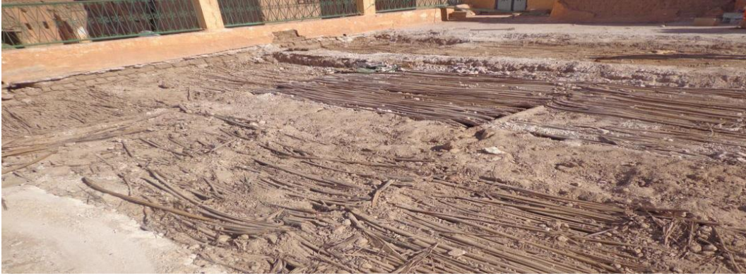
الصورة رقم 12: نزع العوارض الخشبية المهترئة
