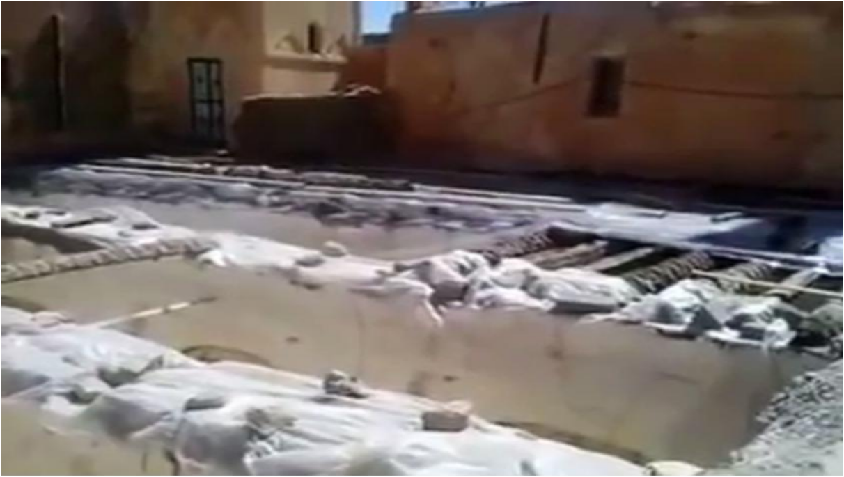
الصورة رقم 15: وضع العوارض الخشبية بطريقة التقليدية
