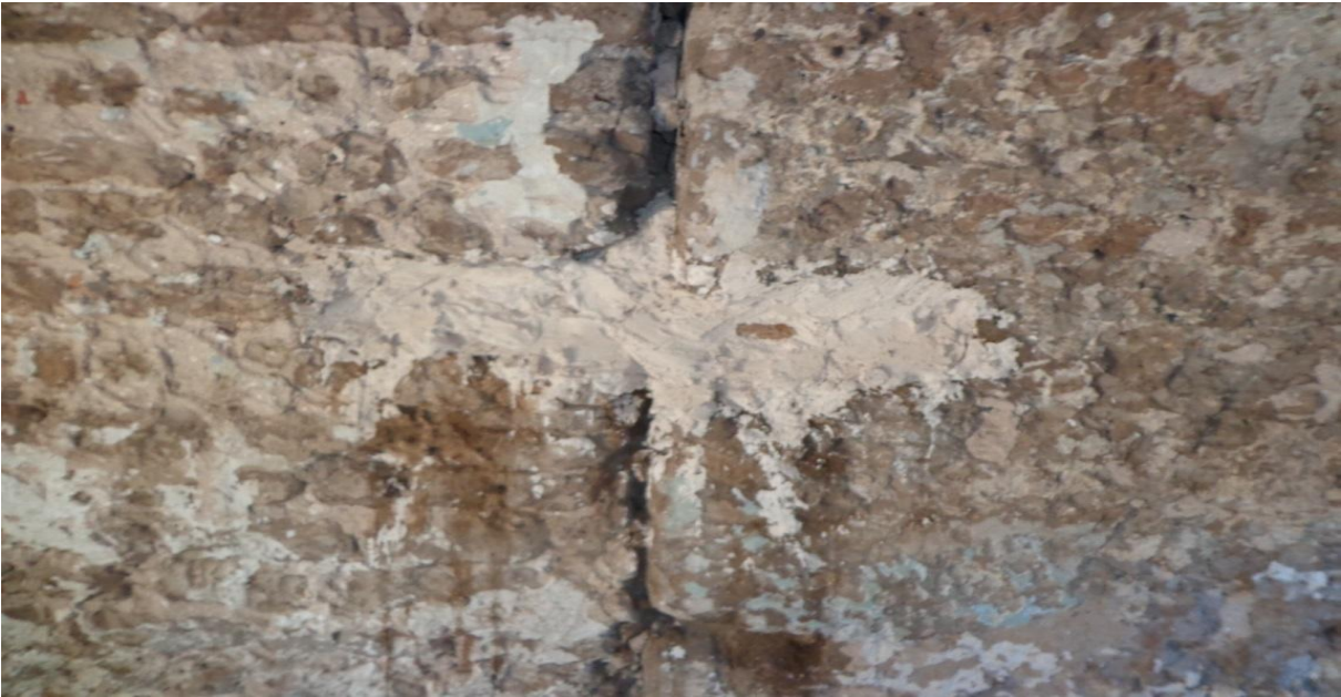
الصورة رقم 17: ترميم التشققات باستعمال مسكات من خشب العرعار
