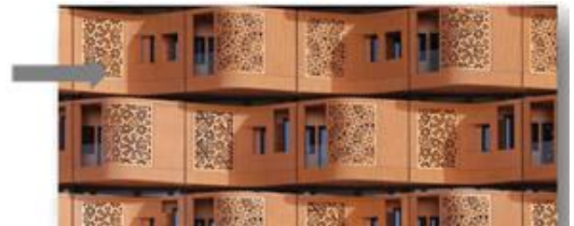
Figure 18: traitement de façade
