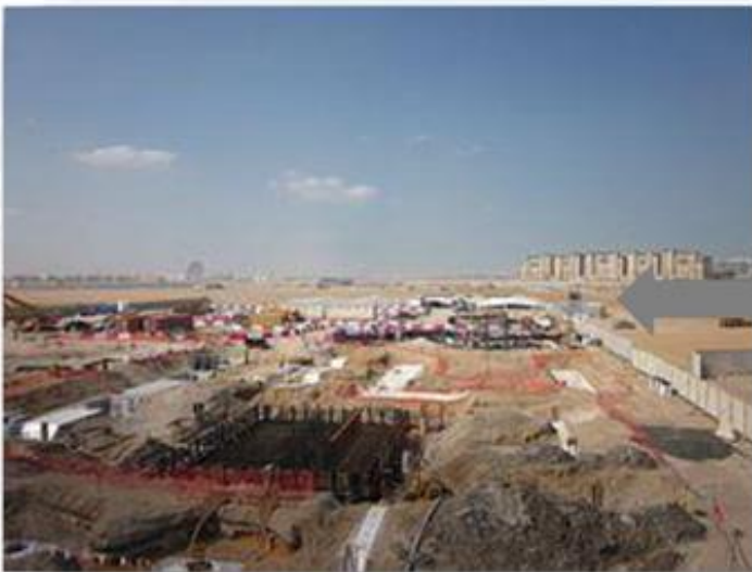
Figure 17 : le projet en court
