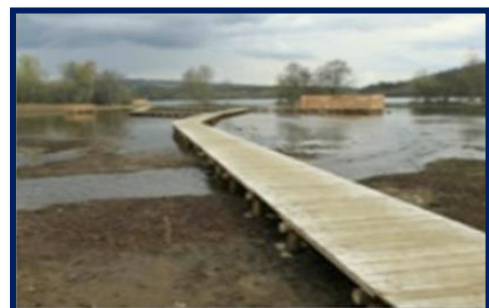
Figure 21: Aménagement d'une passerelle
