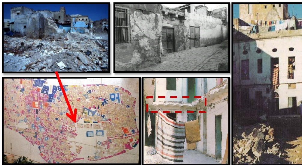
Figure 19: photos des problèmes du quartier El Hafsiya. 59
