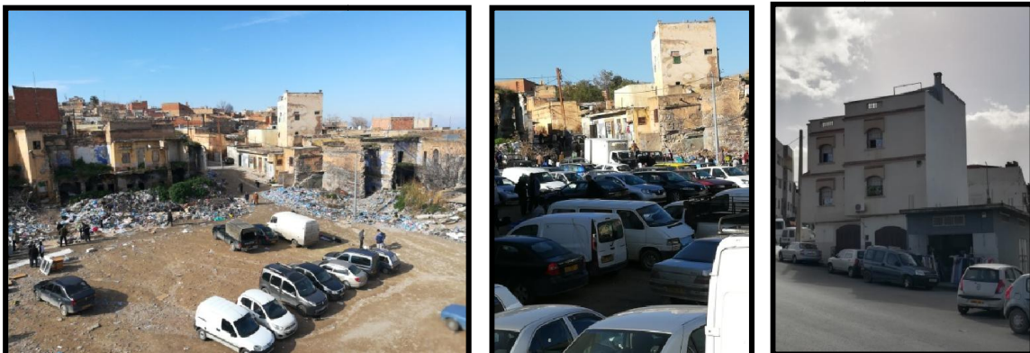
Figure 37:(A gauche)deux photos de parking illicite.(A droite)des constructions dans le terrain d'intervention. 69
