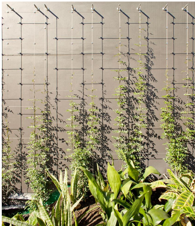
Figure n°19 : Système de plantation pour un mur végétalisé
