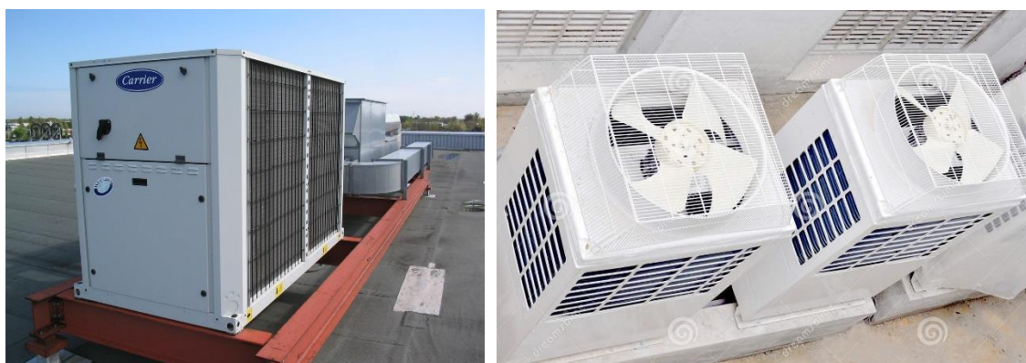
Figure n° 91: Extracteur pour système de climatisation.
