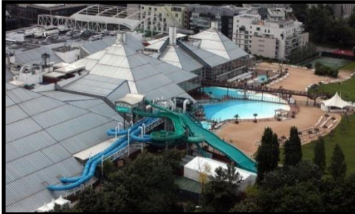
Figure 89. La charpente d'Aqua-boulevard
