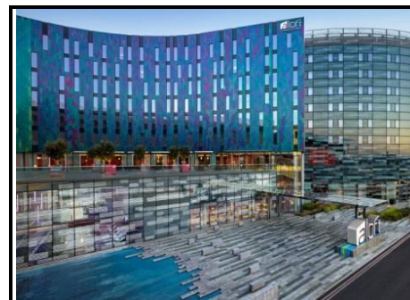
Figure 164. Façade avec un vitrage teinté
