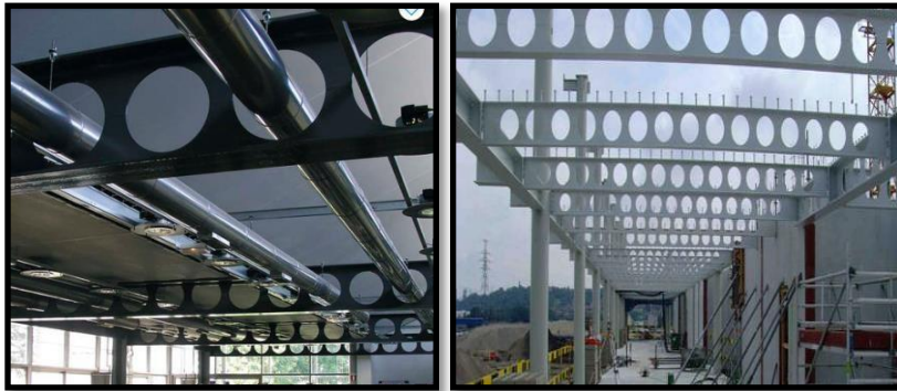
Figure 139. Les poutres alvéolaires
