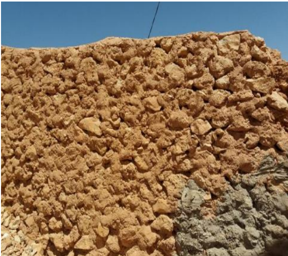
الصورة رقم 15: بقايا السور في الناحية الشمالية من عمل الطالب
