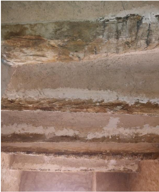
الصورة رقم 40: التسقيف بالأقبية الصغيرة الطابق الأرضي من عمل الطالب
