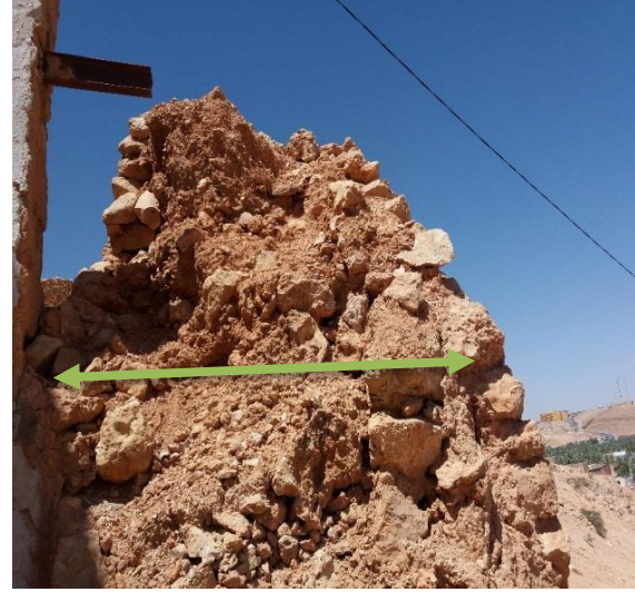
الصورة رقم 16: سمك الجدار والتراب الصلصالي المملوء به جدران السور من عمل الطالب
