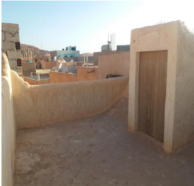
الصورة رقم 84: قضاء من سطح لمدخل الحبس من إعداد الطالب
