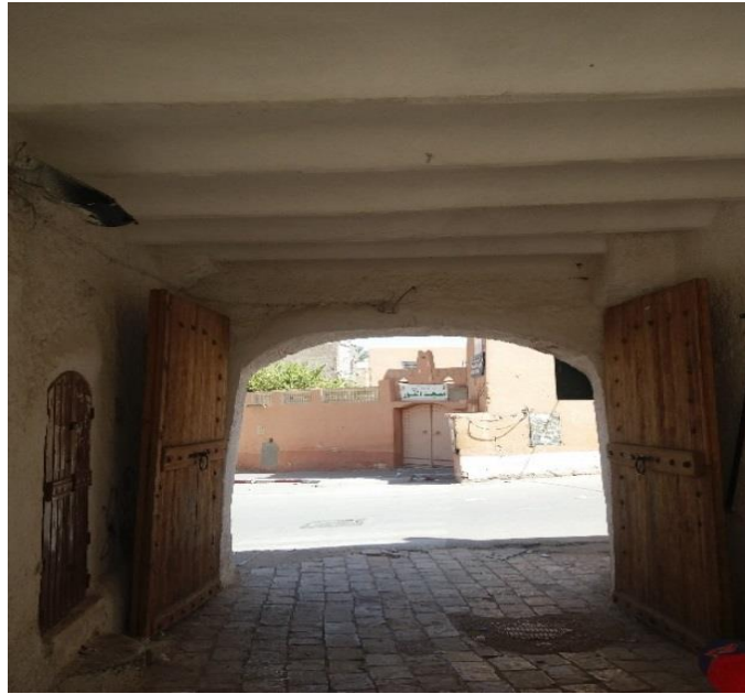
الصورة رقم 100: التسقيف بالعوارض الحديدية للمدخل الشرقي من عمل الطالب
