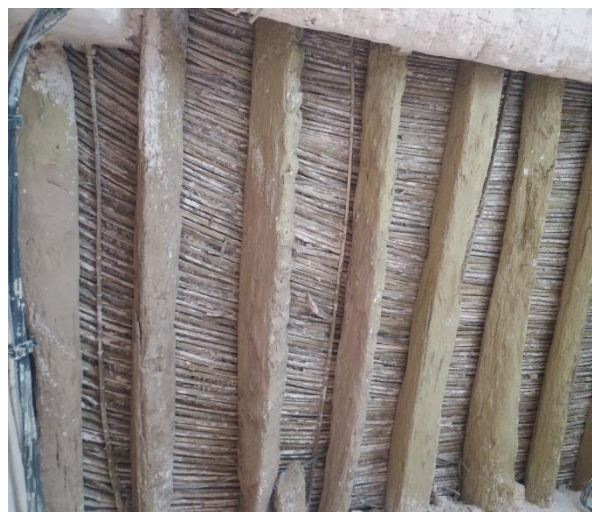
الصورة رقم 85: سقف لمدخل الحبس من إعداد الطالب
