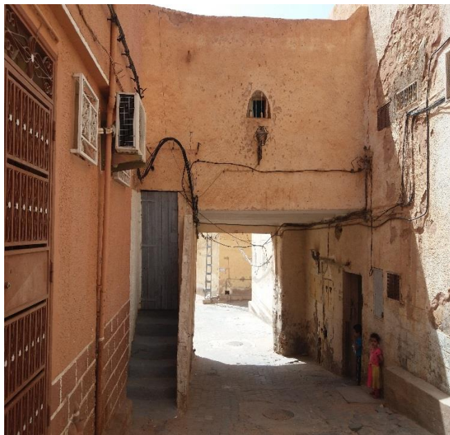
الصورة رقم 88: الواجهة الداخلية للمدخل القبلي من عمل الطالب
