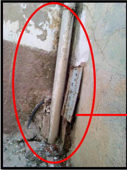
الصورة رقم 06: التأثيرات الناجمة عن أنابيب الماء
