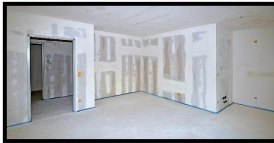
Figure 227: les cloisons sèches<sup>228</sup>
