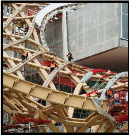
Figure 140: Montage de la charpente et des pièces de fixation de la toile
