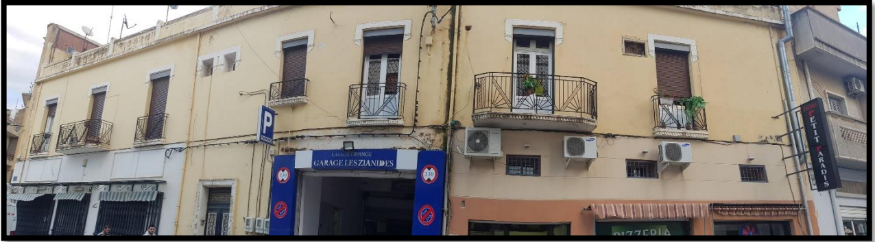
Figure 47: Photo panoramique des habitations de type colonial Source: Auteurs
