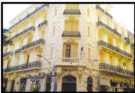
Figure 8: Réhabilitation des immeubles à Oran Source: http://forum.binyen.com
