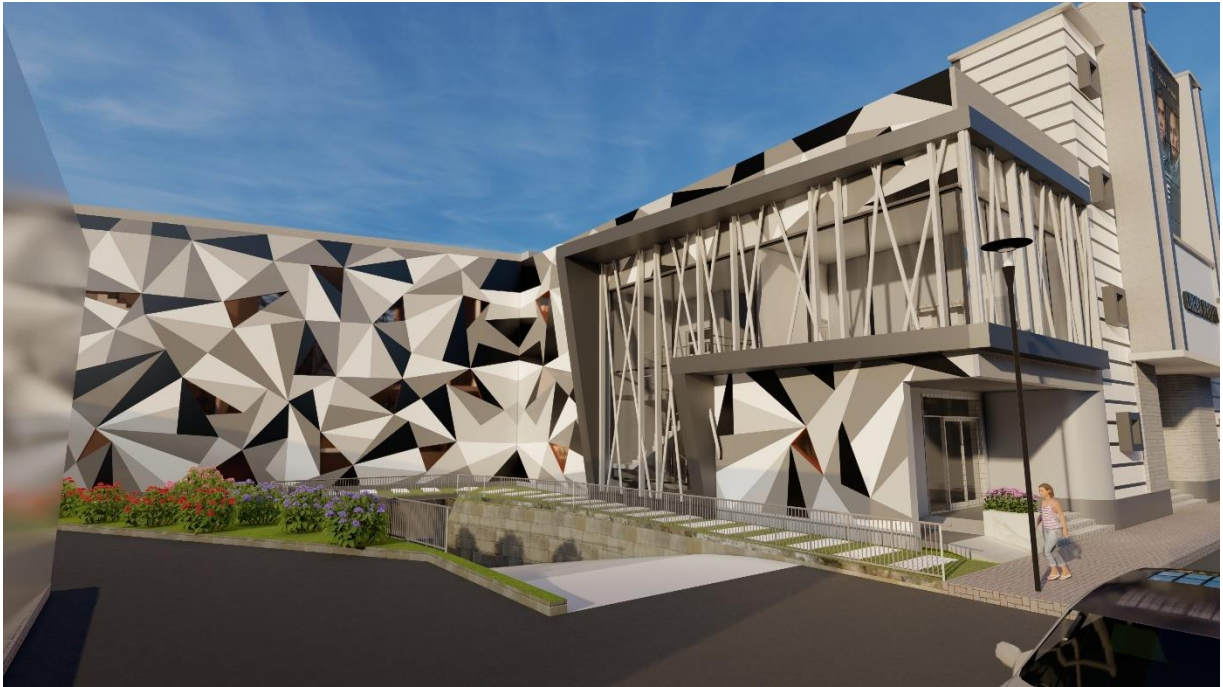
Vue de la façade du bloc B depuis la rue Des Frères Abdeljebar
