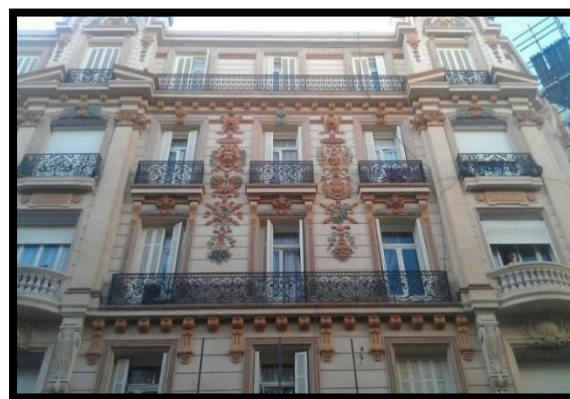
Figure 07: Réhabilitation des immeubles à Oran Source: http://forum.binyen.com
