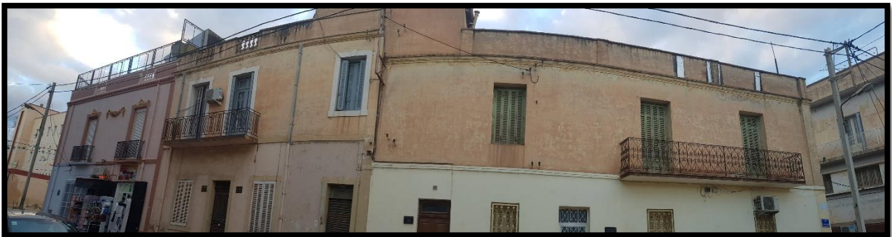
Figure 48: Photo panoramique des habitations de type colonial Source: Auteurs
