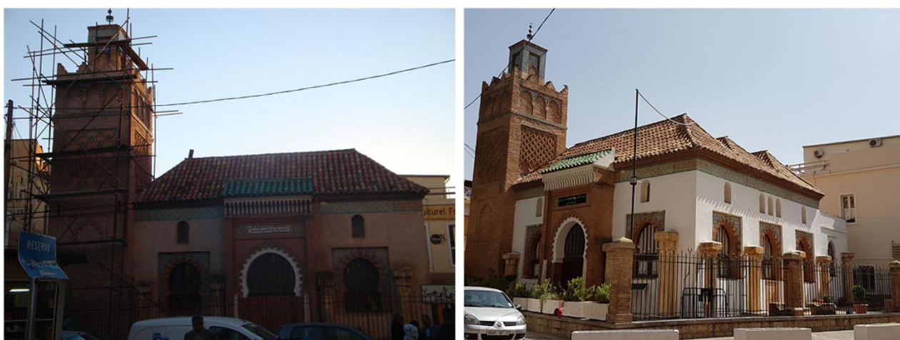
Fig.77 : La mosquée Sidi Belahcen (période Zianide) pendant et après sa restauration. Source : auteur
