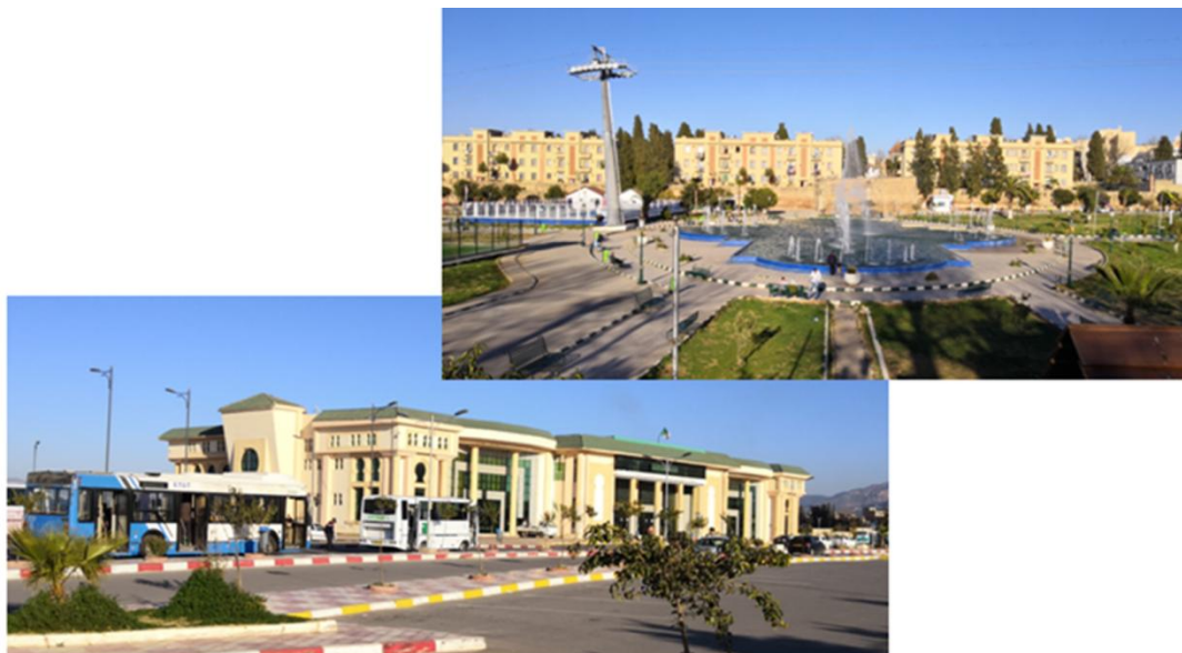
Fig.66 : Le téléphérique et la gare routière de Tlemcen Source : auteur
