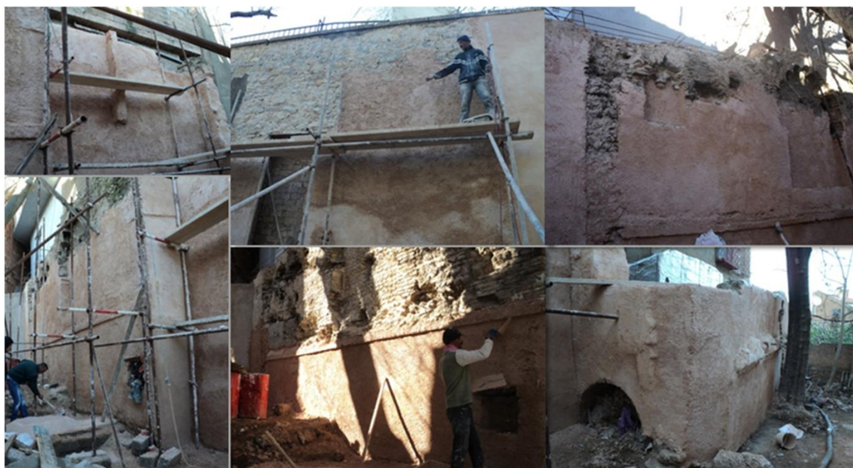
Fig.76. Bab El Qayssaria (période Zianide) pendant sa restauration Source: OGEBC
