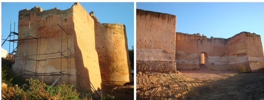
Fig.72: Bab El Qarmadine (période almoravide) pendant et après sa restauration Source : auteur
