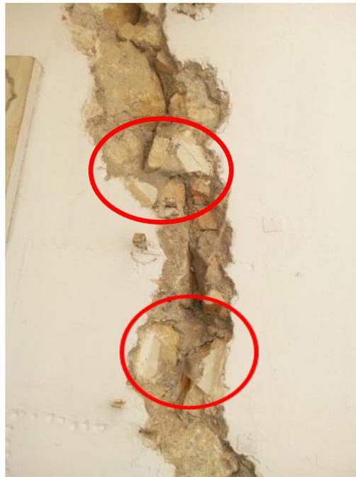
الصّورة (33): تبين اختبار زيادة التشقق اثر الهزّات الأرضية المتكررة بالمتحف الوطني الاثار القديمة
