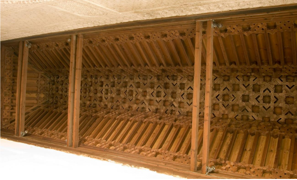
الصورة رقم 11: مسجد سيدي أبي الحسن التنسي، السقف
