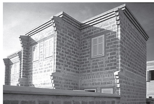
(b) Logements en blocs de terre stabilisés à Marrakech, programme REXCOOP/ERAC (©CRATerre-EAG).
