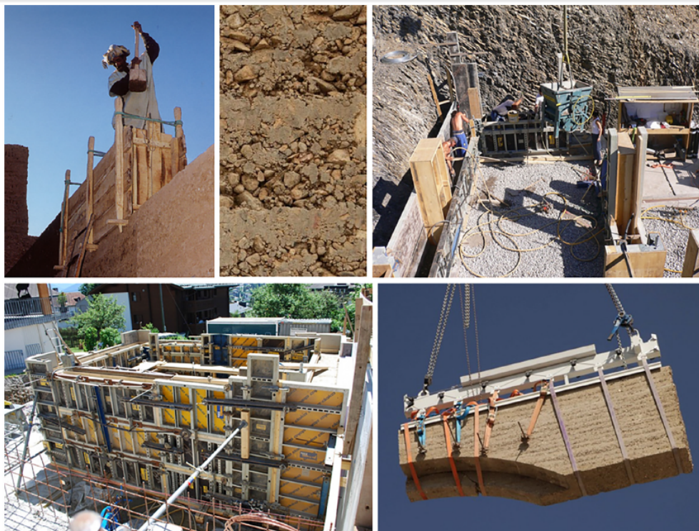
FIGURE 4.9 – La technologie de la terre pisé :1.compactage dynamique traditionnel à la main avec un petit coffrage en bois mobile, Afrique, 2.Un regard étroit sur un mur de terre pisé, montre les couches compactées, 3 et 4 une construction moderne en pisé ( l’Autriche), 5.Un élément préfabriqué mis en place (l’Autriche et suisse), [Van-Damme and Houben, 2017].
