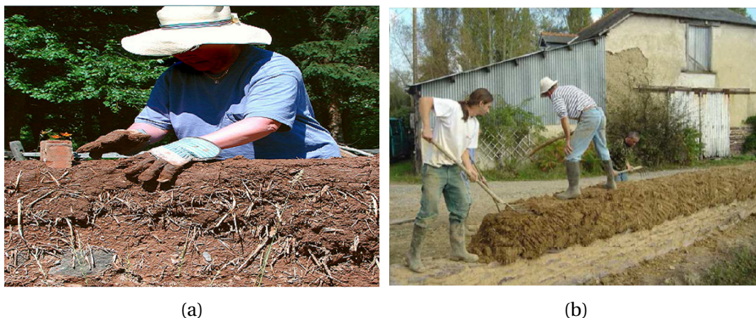
FIGURE 4.17 – Le système de construction monolithique en terre crue empilée (bauge).
