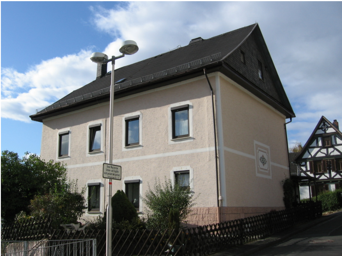
FIGURE 4.6 – une école construite en pisé à Bonbaden, (en Allemagne).
