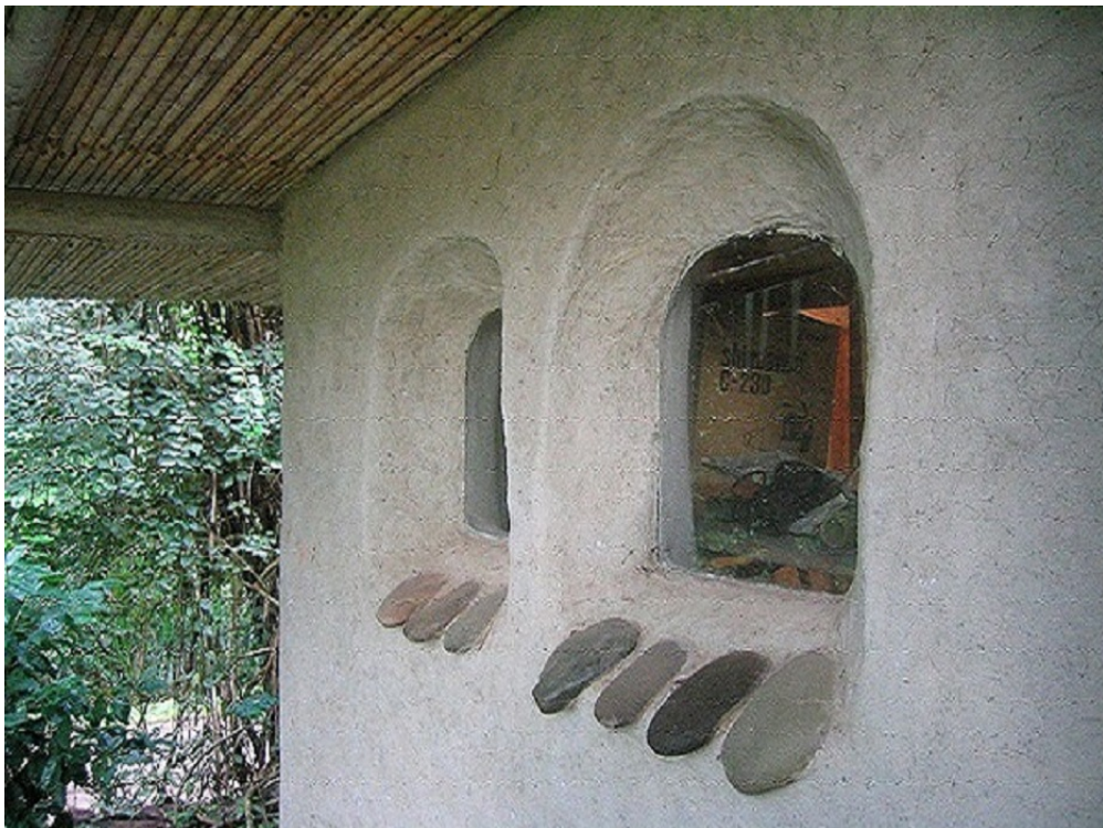
FIGURE 4.16 – La construction en bauge au Costa Rica.
