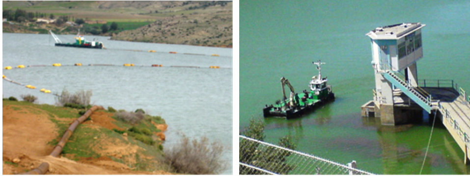
(a) système de dragage vers les bassins (b) (la drague stationnaire suceuse- re-fouleuse)
