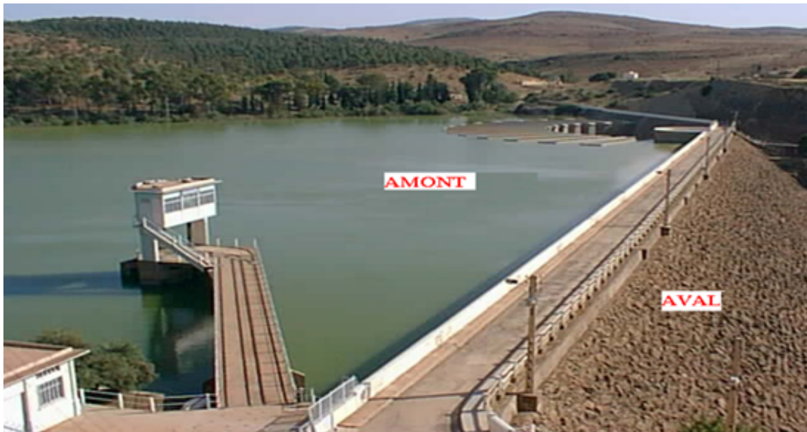
FIGURE 5.2 – la digue du barrage de BAKHADDA.
