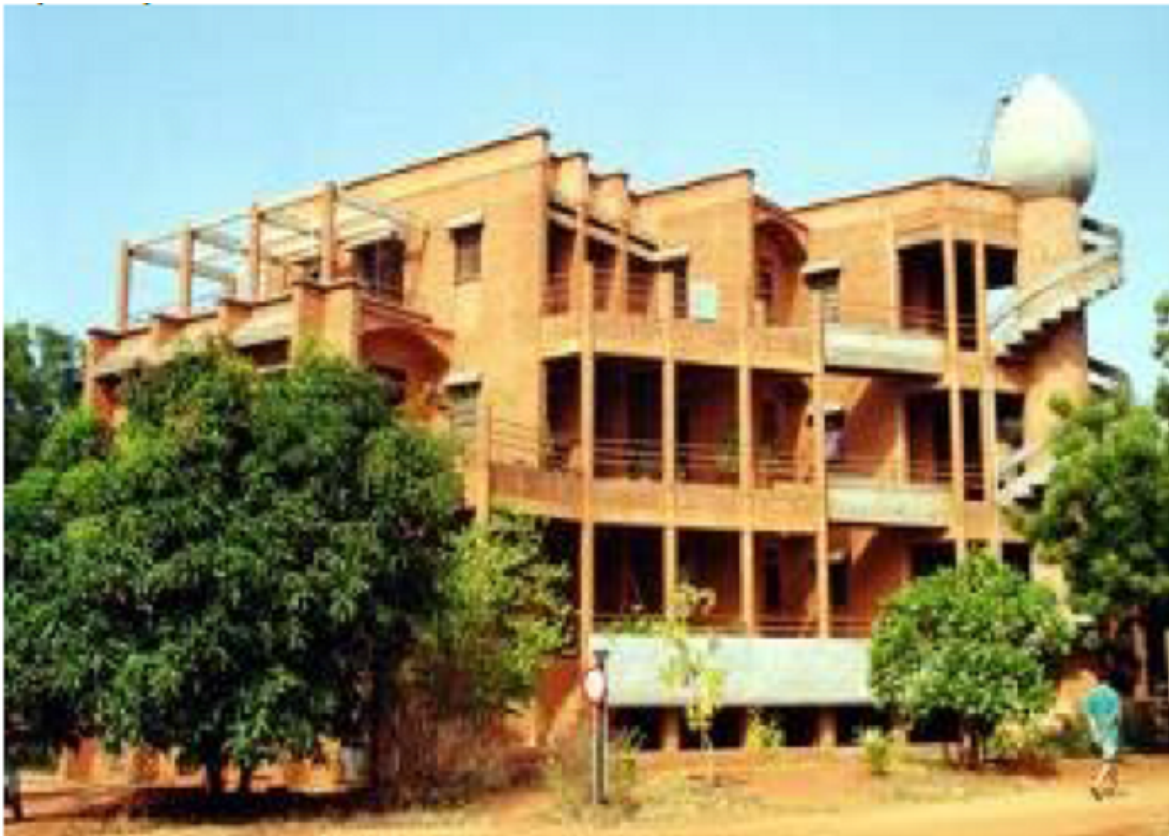
(b) Bâtiment en terre stabilisée sur 4 étages en INDE
