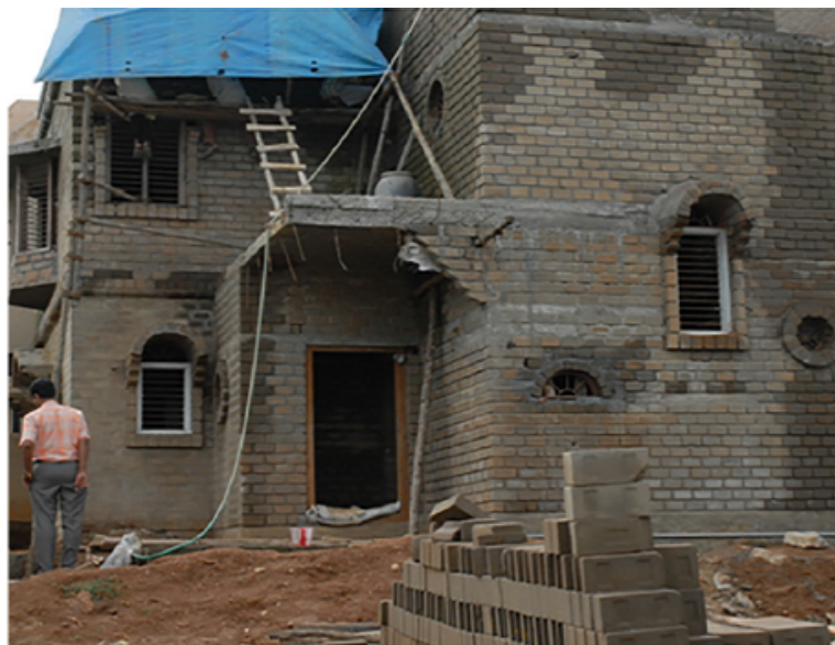
FIGURE 4.19 – La construire en blocs de terre compressée stabilisés (BTCs) à Bangalore, Inde, 2007.
