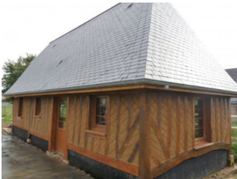
FIGURE 4.13 – La construction d'une maison en colombage et torchis près de Rouen, FRANCE.
