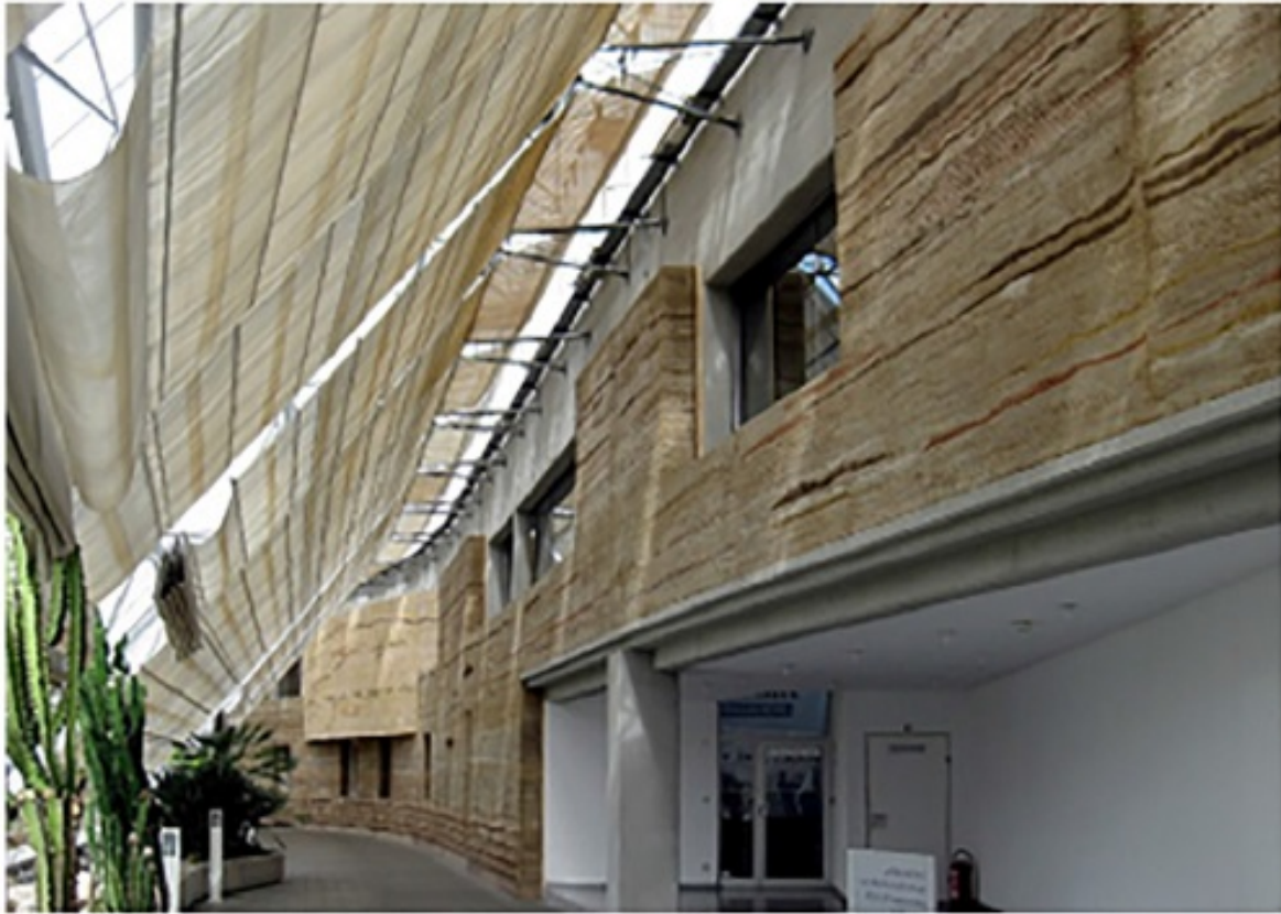
FIGURE 4.7 – Hôpital régional de Feldkirch, Vorarlberg, Autriche, 1993, [Van-Damme and Houben, 2017].
