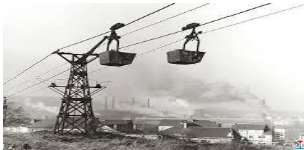
Figure I.7 : Convoyeur à câble [10]
