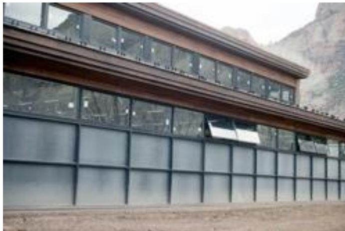
Figure 2.1 : Mur Trombe du parc national Zion, Utah Etats Unis, étudié par Torcellini et Pless (2004) [9]
