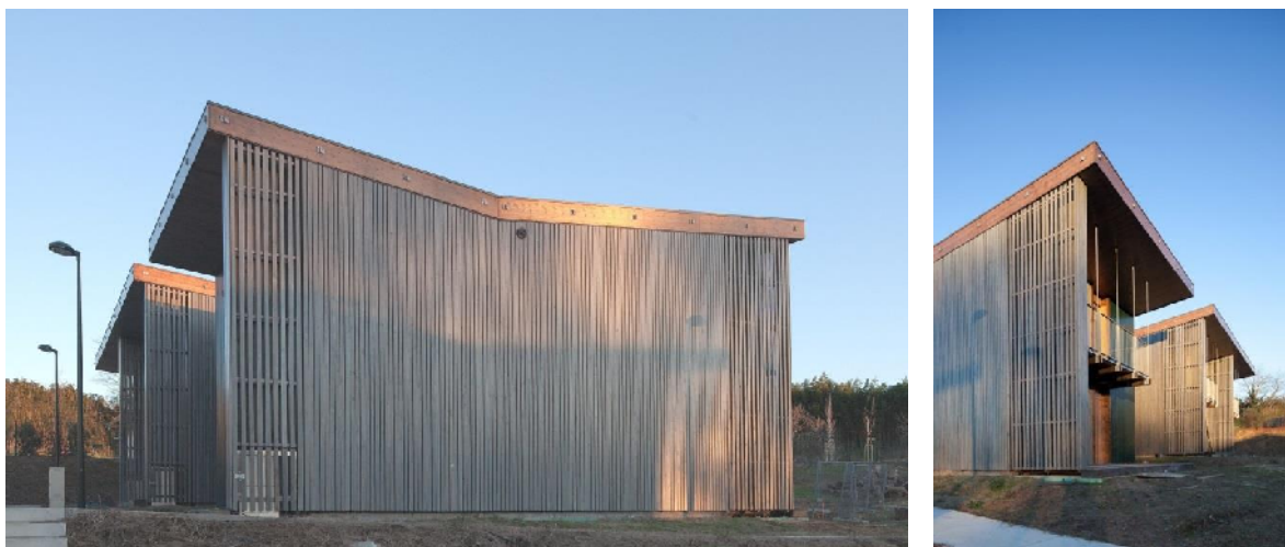
Figure 2.4 : Exemple des maisons du quartier Arroussets à Bayonne qui intègrent un bardage pin maritime ventilé devant une isolation par l'extérieur [9]
