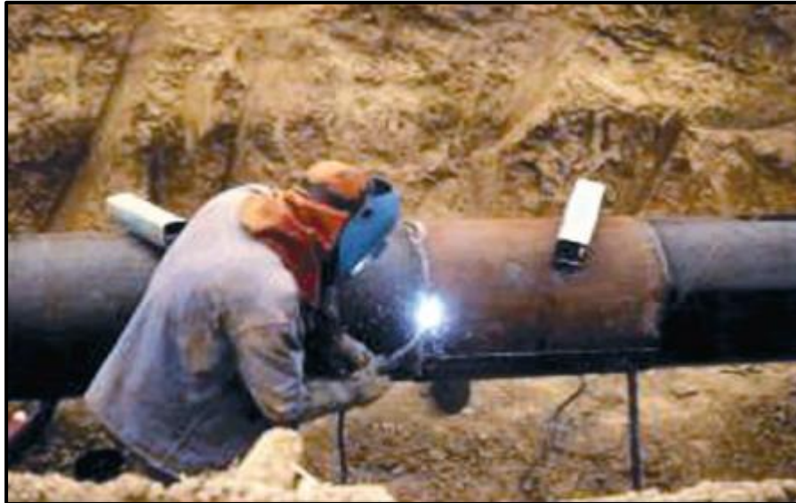
Figure I 17 : Opération de soudages de demi coquilles (STT) [11].
