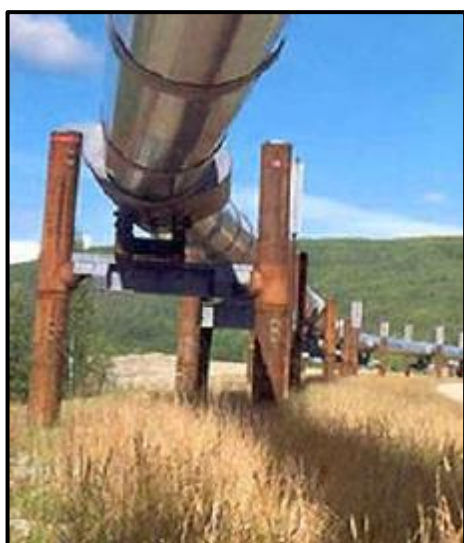
Figure I.2: Canalisation aérienne [9]
