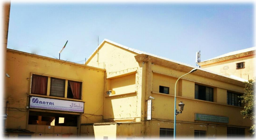
Photo 3.3 Site 3 : 45 Boulevard Mohamed V Tlemcen
