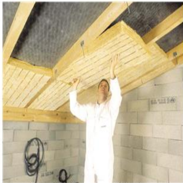
Figure 1. 32 : Mise en place de panneaux de laine de verre [3]
