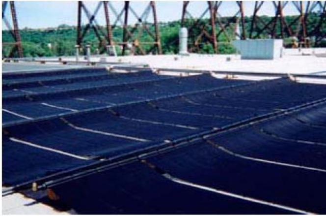
Fig.II. 2: Capteur solaire moquette.
