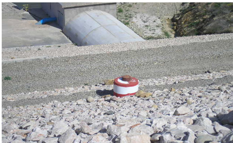
Figure II.3 : Borne sur talus aval servant aux mesures des déplacements Barrage Sidi Abdelli, wilaya de Tlemcen (Smail, 2007)
