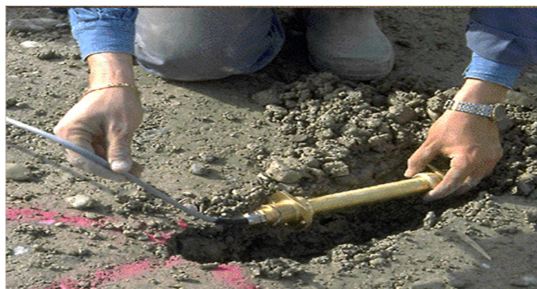
Figure II.17 : Installation au niveau d'un remblai de l'extensomètre à corde vibrante (EDF et Cemagref 1998)
