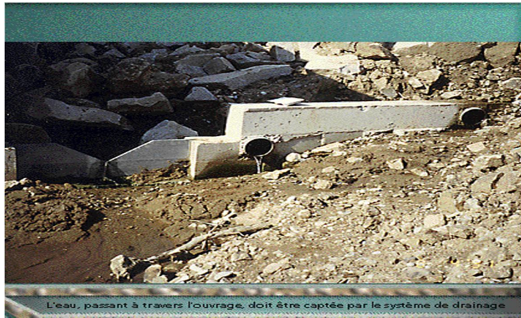
Figure II.32 : Débit de drainage collecté au niveau du barrage de Sikkak, wilaya de Tlemcen (Smail, 2007)
