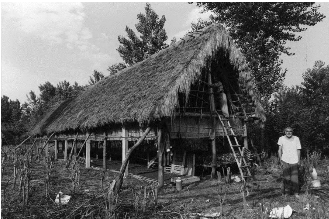
Photo 4 : Type de construction gilanie
