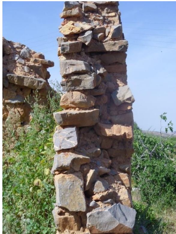
Photo 31 : Type de pierre et appareillage Source : Auteur
