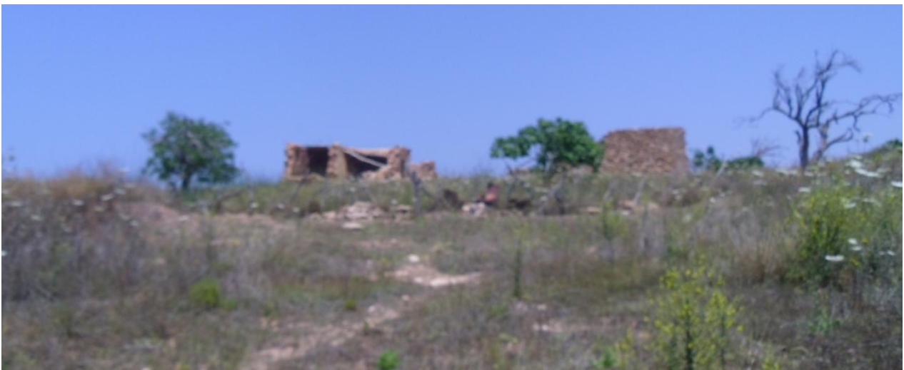
Photo 34 : Vue générale du deuxième cas d'étude Source: Auteur
