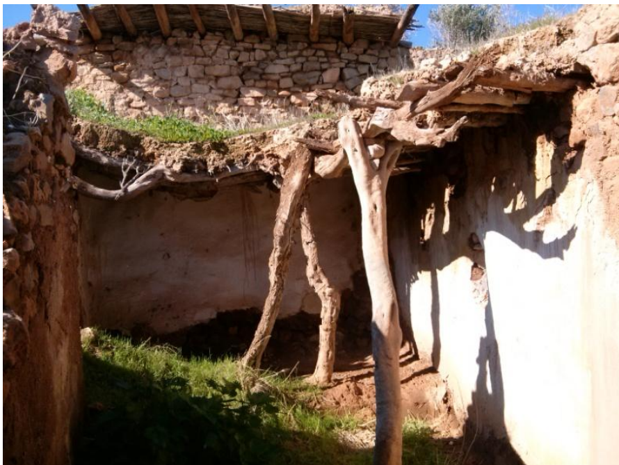
Photo 29 : Rkiza (pilier en bois) Source : Auteur
