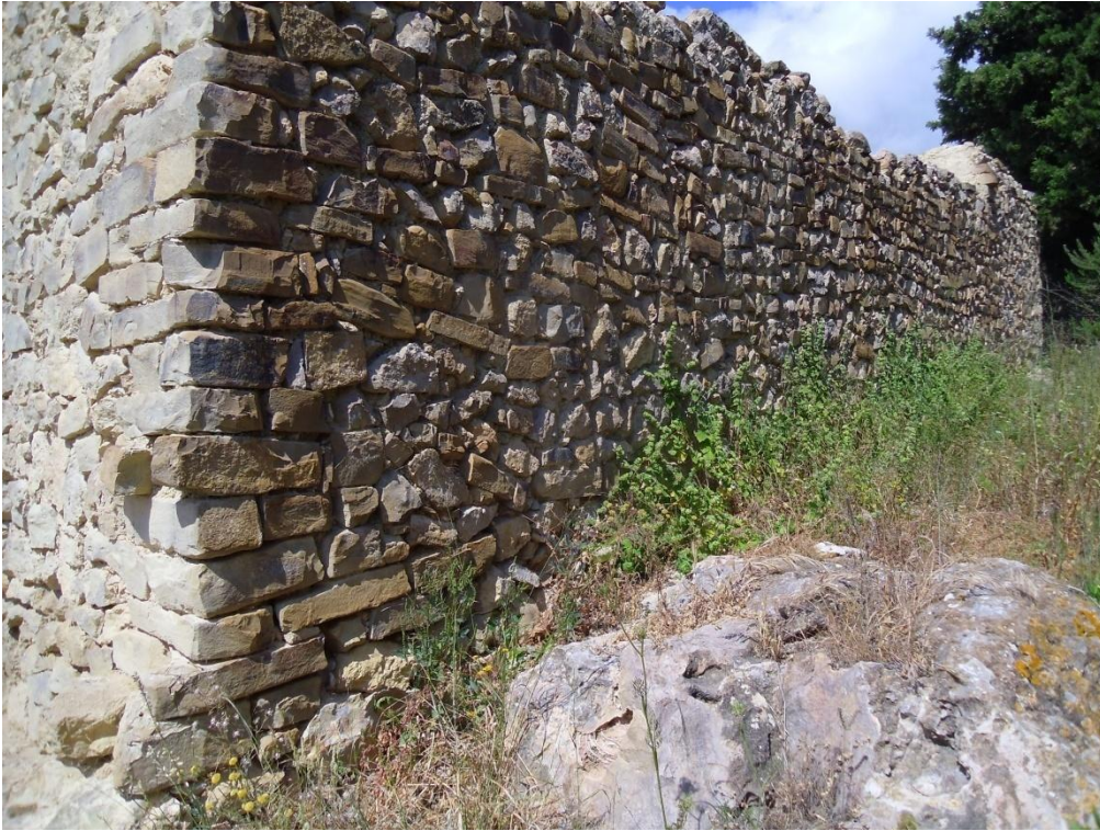
Photo 52 : Murs posés directement sur le terrain rocheux Source: Auteur
