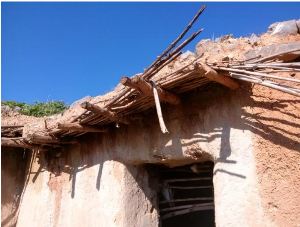
Photo 26 : Sur la façade de L'bit, L'hadjeba Source : Auteur
