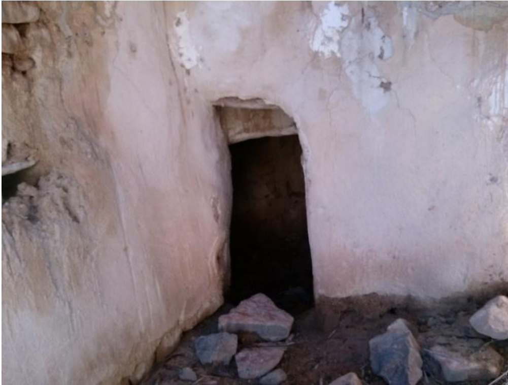
Photo 25 : Sur la façade de L'bit, L'hadjeba Source : Auteur
