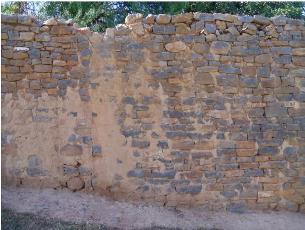
Photo 27 : Type de pierre et appareillage Source: Auteur
