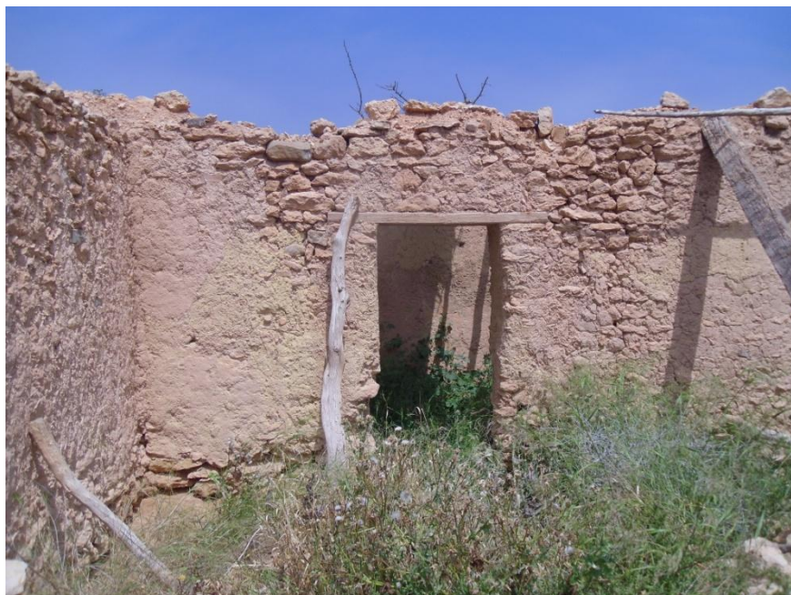
Photo 38 : L'accès à Lbit -Ihadjeba- Source: Auteur
