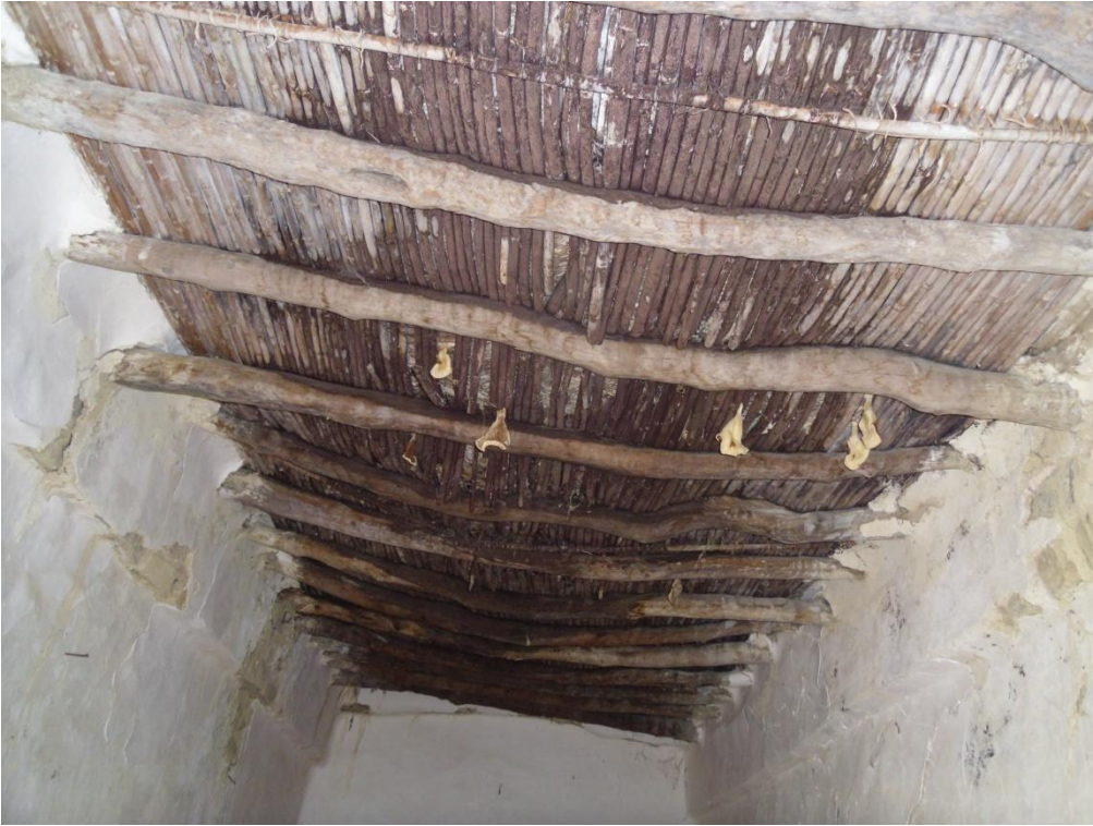
Photo 56 : Plancher en bois à travure simple Source : Auteur
