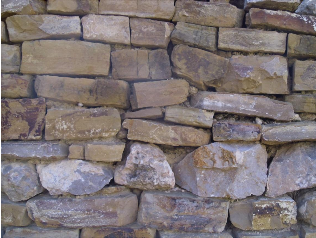
Photo 54 : Appareillage du mur Source : Auteur
