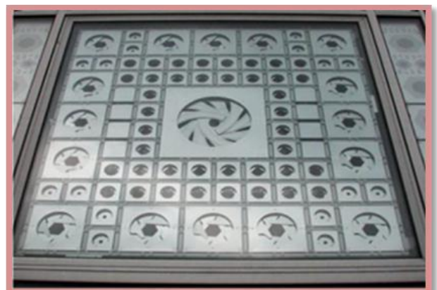
Figure 37: IMA -Vue sur la façade Sud Traitement en Moucharabiés / Source : www.lightzoomlumiere.fr
