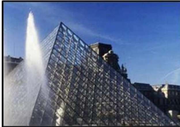
Figure 66: exemple Structure métallique en triller Le Louvre a paris /Source www.getyourguide.fr
