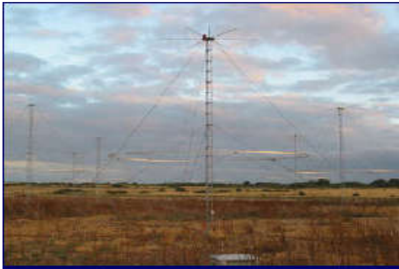
Figure I.11. Le Radar Nostradamus conçu de 288 éléments d'antenne
