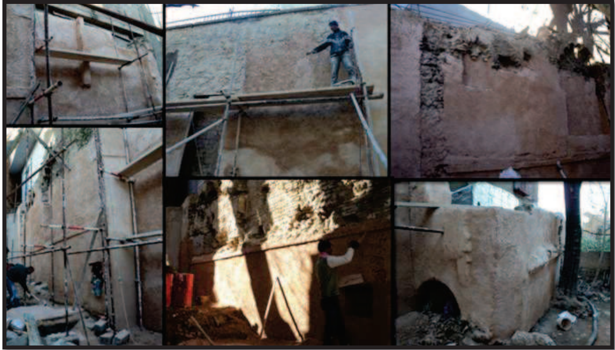
Fig.90: Restauration des murs de Bab El Kissaria Source: O.G.B.C.P
