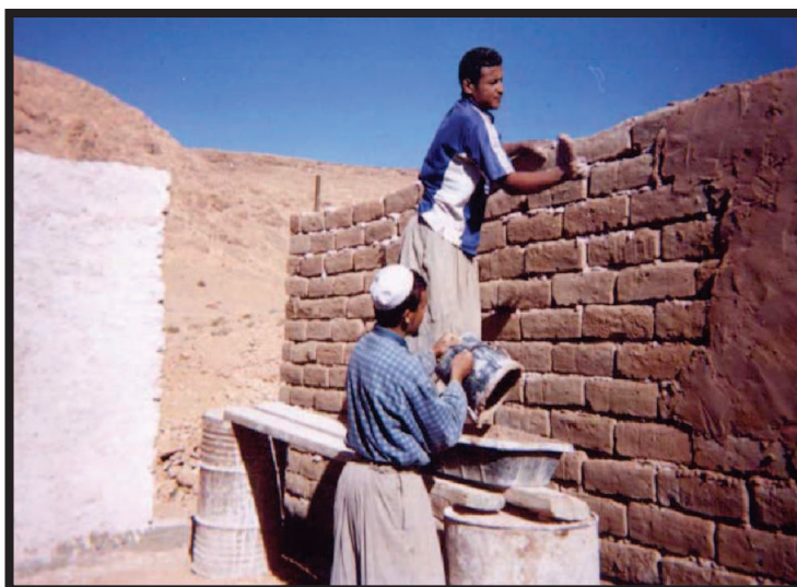
Fig.30: la participation des citoyens dans les travaux de restauration de la vallée du M'zab Source : M.Ballalou Zoubir 151
