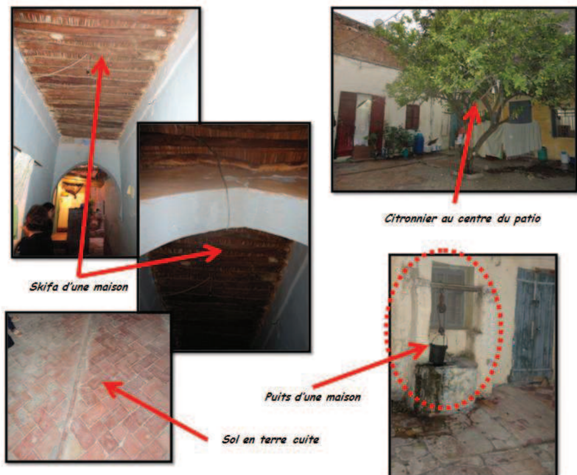
Fig.104: éléments caractérisant les maisons du quartier R'hiba Source: auteur -2011-
