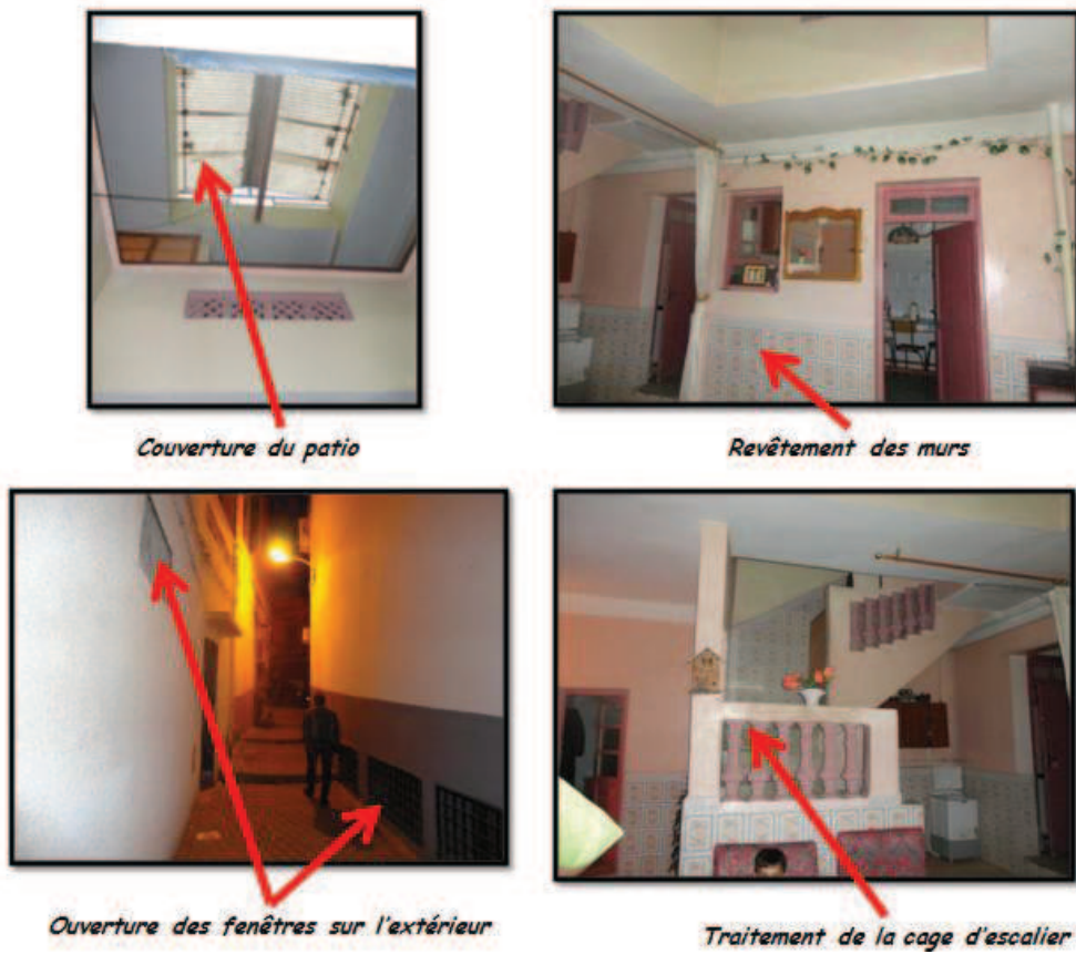
Fig.109: Les modifications effectuées sur les maisons traditionnelles Source: auteur -2011-
