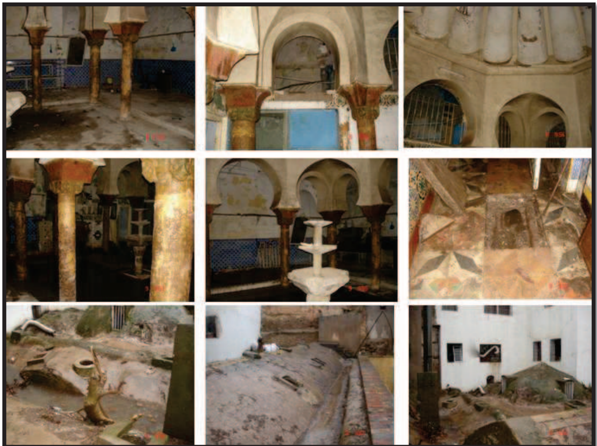
Fig.93: Les travaux de restaurations de Hammam Essebaghine Source: O.G.B.C.P
