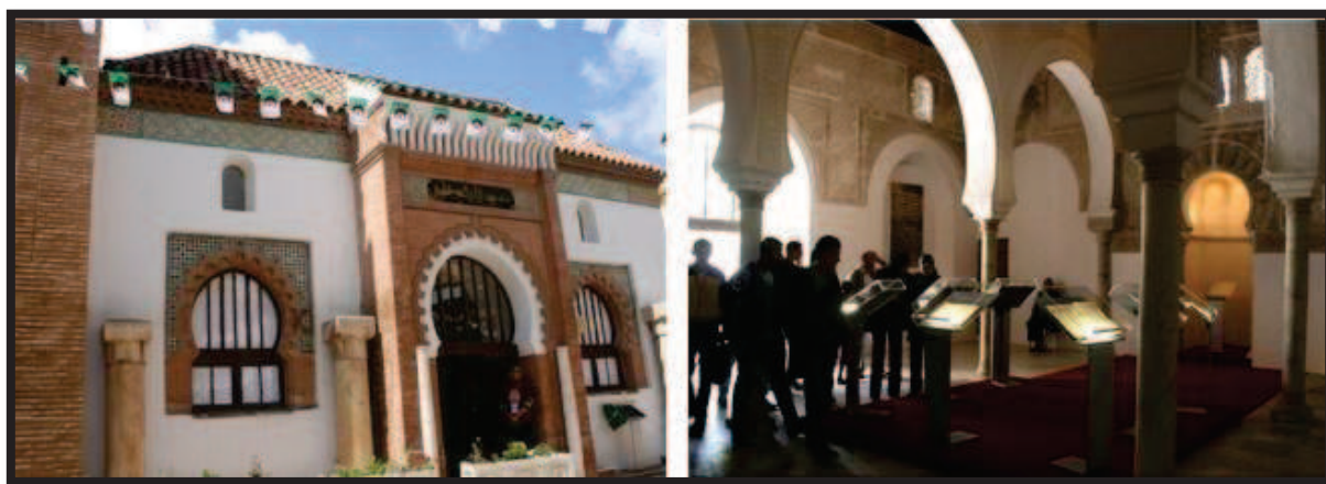
Fig.68: La mosquée de SIDI BELAHCEN après les travaux de restauration. Source : http://www.tlemcen2011.org
