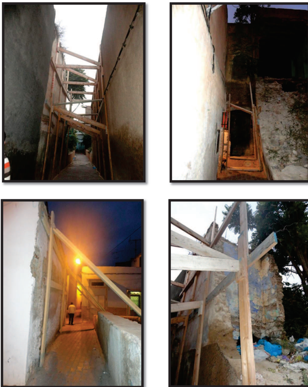
Fig.107: les consolidations des maisons Source: auteur -2011-
