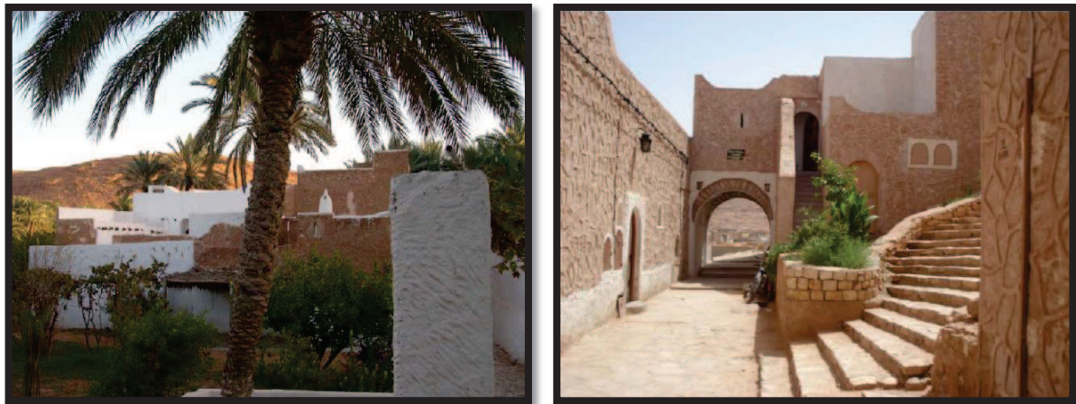
Fig.27 : Ksar après restauration Source : M.Ballalou Zoubir 148
