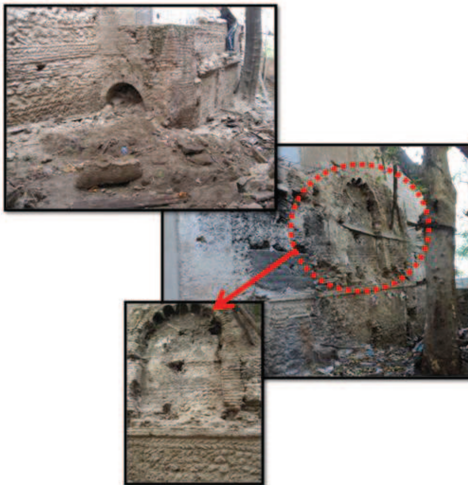
Fig.89: décapage des murs de Bab El Kissaria Source: O.G.B.C.P
