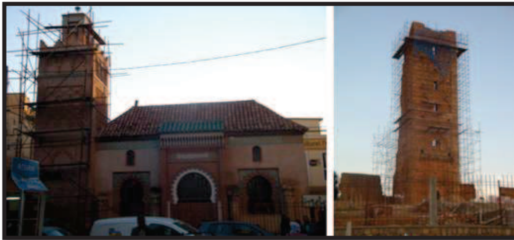
Fig.66 : La restauration de la mosquée de SIDI BELAHCEN. Fig.67: le minaret de MANSOURAH Source : auteur 2010
