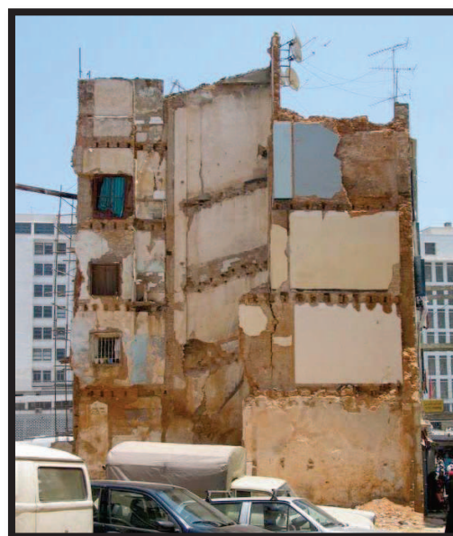
Fig.25 : la partie basse de la Casbah d'Alger Source : Larbi Icheboudene 141
