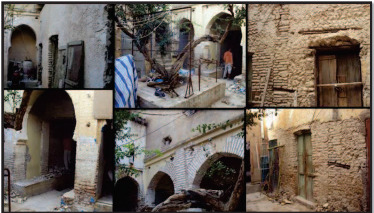
Fig.91: Le décapage des murs du fondouk Roumana Source: O.G.B.C.P
