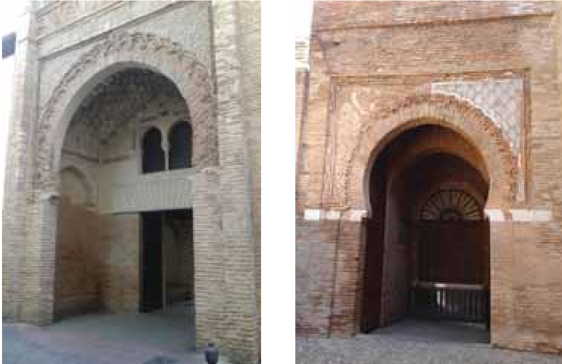
Figure 74 : Arcs dentelés nasrides semblables à ceux de Tlemcen. (À gauche, Caravansérail à Grenade ; à droite, Porte de la justice, l'Alhambra de Grenade). Source : auteur.
