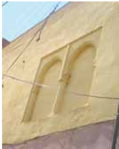
Figure 82 : Baie géminée remontant à l'époque ottomane. (Derb Nâaydja, actuellement).
