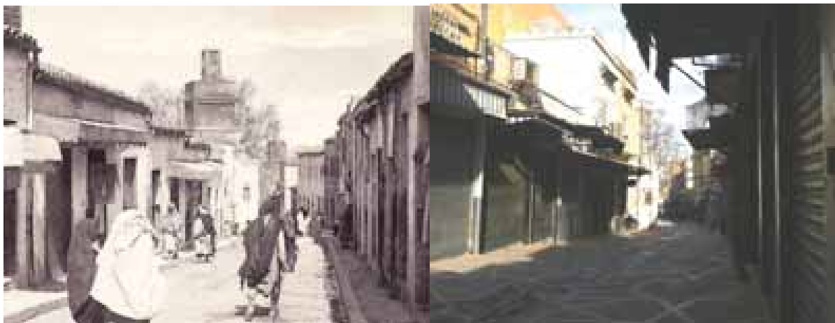
Figure 124 : Surélévations faisant disparaître les minarets. (En haut, Derb Ouled Sidi El Imam ; en bas, rue de Mascara).
