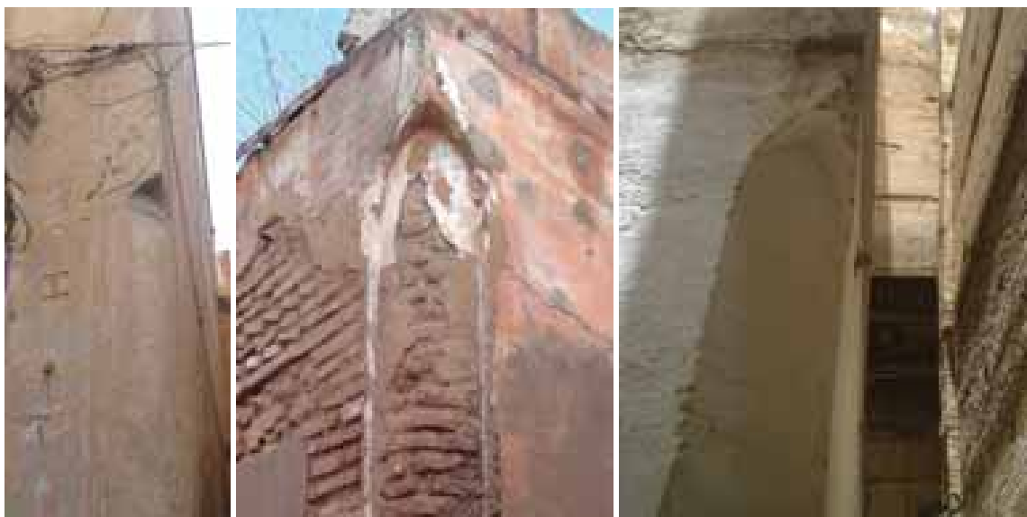
Figure 63 : Pans-coupés avec arcs d'angle. (À gauche et au centre, Tlemcen ; à droite, Fès). Source : auteur.
