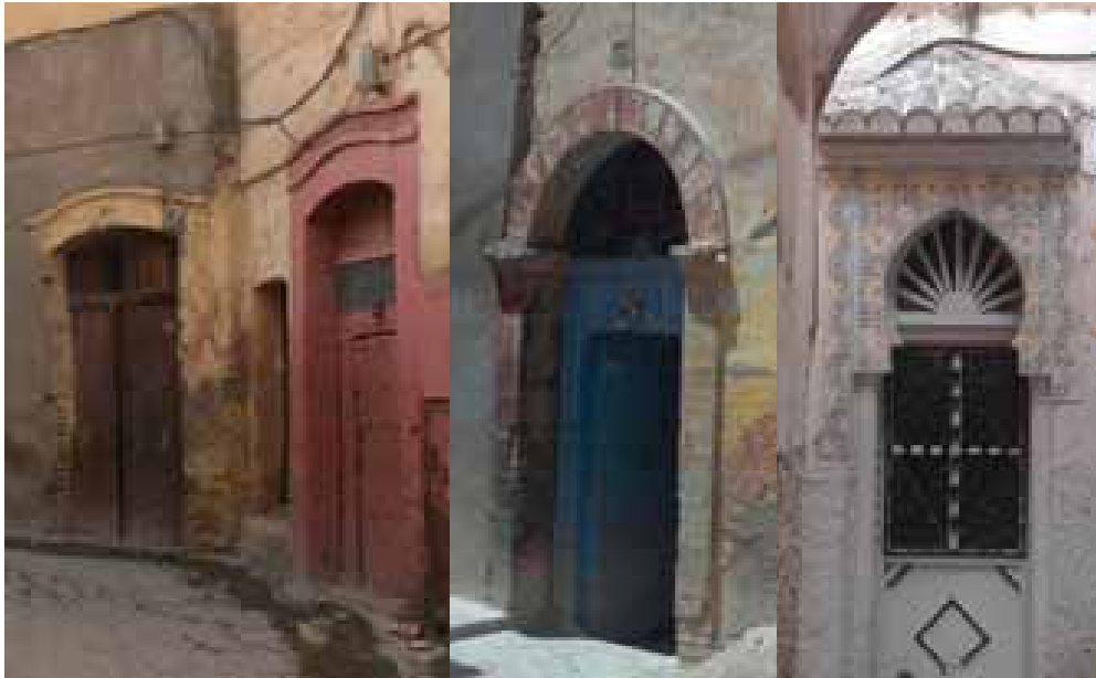
Figure 70 : Portes atypiques dans la médina de Tlemcen.
