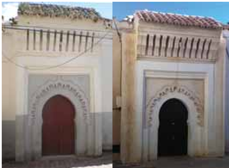
Figure 30 : La restauration de la porte de la mosquée de Sidi El Yeddoun.
