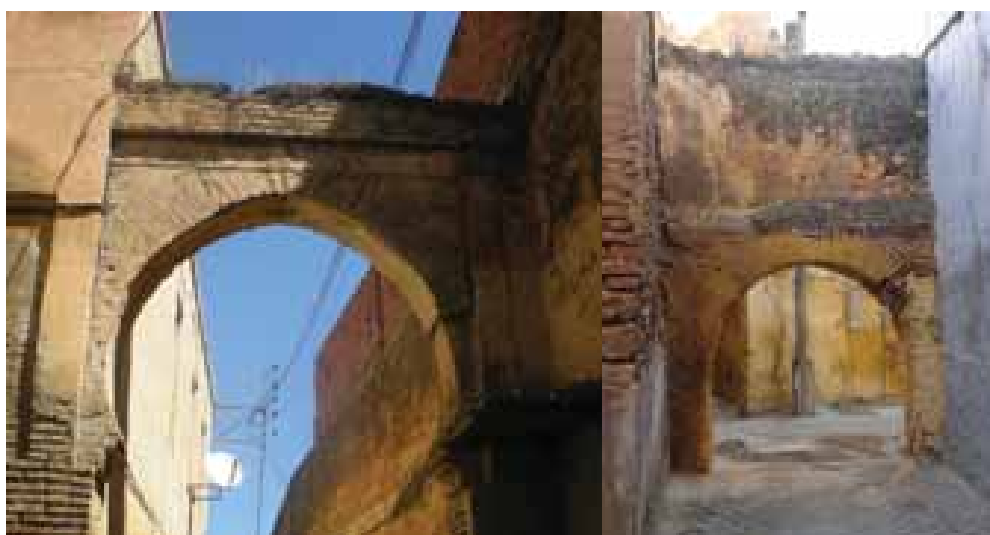
Figure 55 : Arcs d'entretroisement dans des ruelles relativement larges, Tlemcen. (À gauche, Derb Sensela ; à droite, Beni Djemila).
