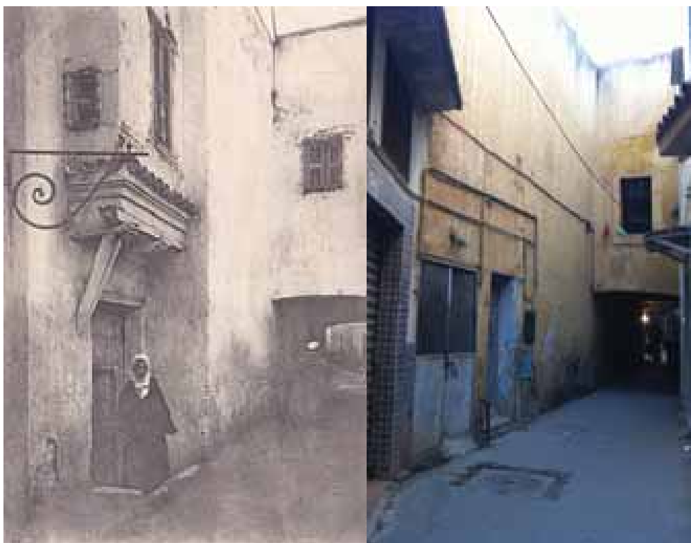
Figure 114 : Cas de dépouillements de l'architecture de la médina, rue des Forgerons.
