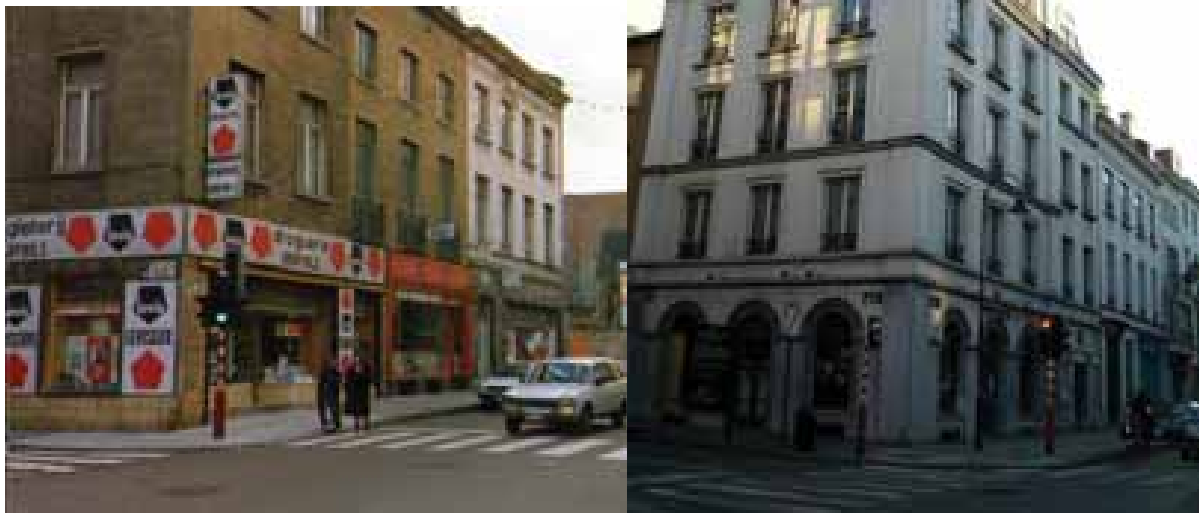
Figure 10 : L'angle de la rue Laeken et la rue de Pont Neuf, avant et après les travaux. (nous pouvons percevoir l'un des deux immeubles retenus ; le deuxième possède une façade à fronton triangulaire, voir figure précédente)
