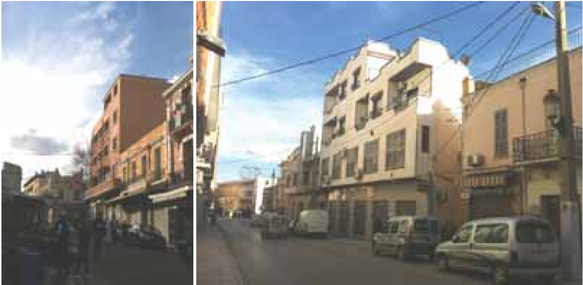
Figure 119 : Rupture de gabarits dans le paysage urbain. (À gauche, rue de la Paix ; à droite, rue Bel-Abbès ).
