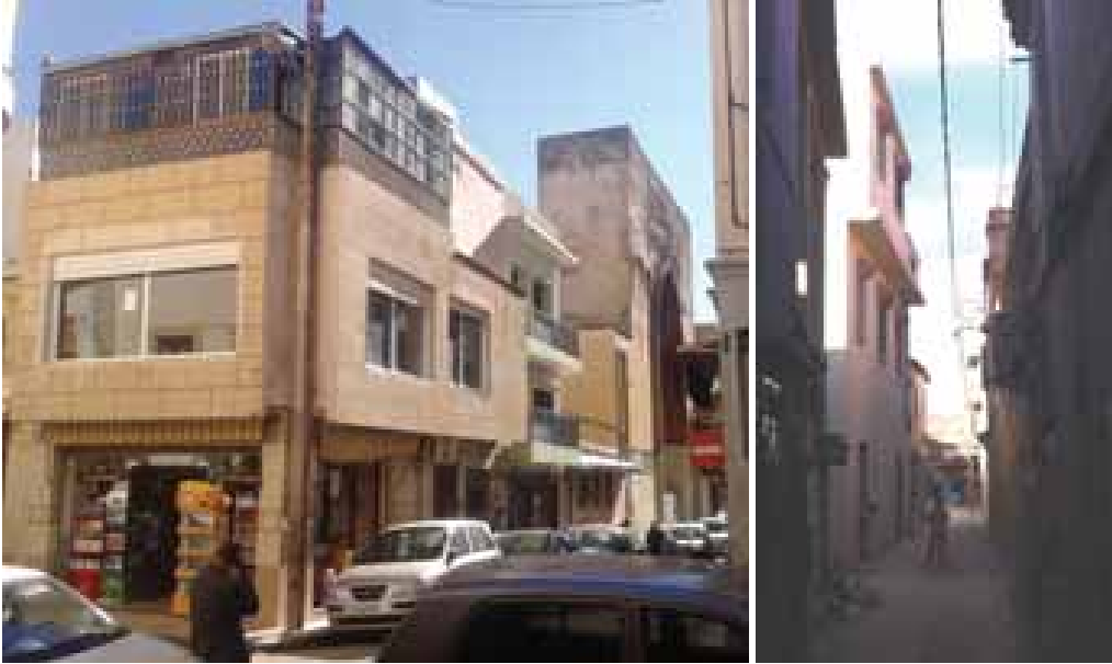
Figure 118 : L'apparition d'une nouvelle esthétique avec la généralisation du béton.
