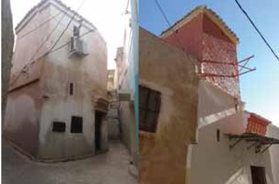
Figure 40 : À gauche, Minaret de la mosquée Lalla el-Gharîba ; à droite, Minaret de la mosquée Sidi Djebbar.
