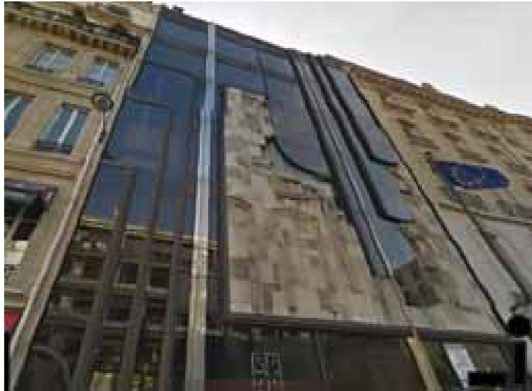
Figure 13 : Vue sur l'immeuble du 22, rue Matignon à Paris.
