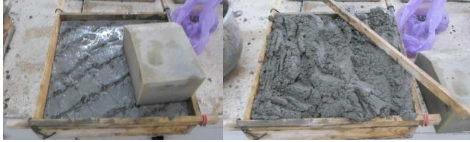
Etape 1. Mouillage de la surface des dalles en béton.
