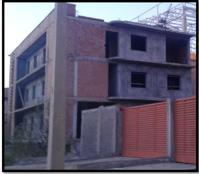
Entreprises en cours de réalisation
