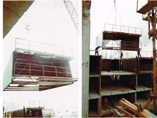
Figure 71. Unité de coffrages Tunnels sur chantier (Source: batimetal, 1970).
