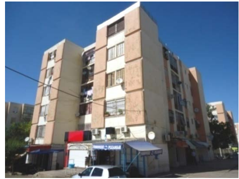
Figure 90. Vue de l'extérieur du bâtiment contenant le cas d'étude, cité 1060 logements, quartier d'Imama-Mansourah à Tlemcen.
