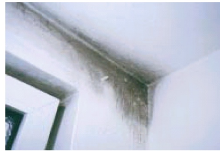
Figure 41. Phénomène du pont thermique (Source : APUR, 2011)
